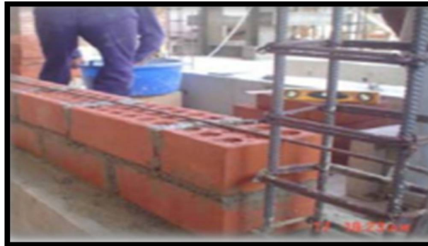
FIG. N° 11 DESCRIPCIÓN: Muro Confinada A Ras (con chicotes).
