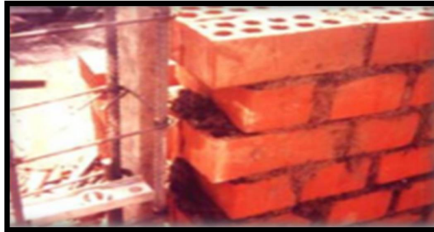
FIG. N° 10 DESCRIPCIÓN: Muro Confinada Dentada.
