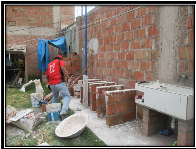
FOTOGRAFÍA N° 54: COLOCACIÓN DE CAPPING EN LA SUPERFICIES EN CONTACTO CON LAS ESCUADRAS DE CARGA.
