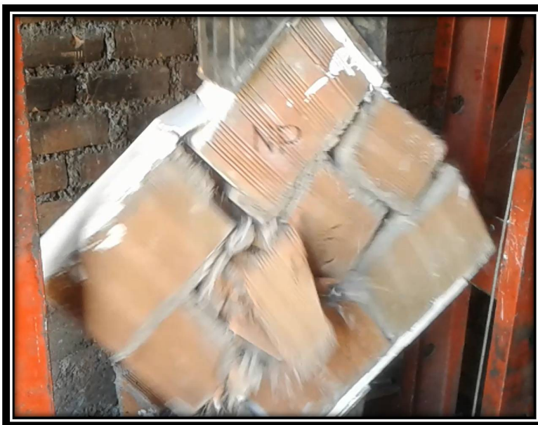
FOTOGRAFÍA N° 49: FALLA EN EL ESPÉCIMEN (MURETE DE ALBAÑILERIA), CON MORTERO TIPO NP, FALLA DE FORMA EXPLOSIVA
