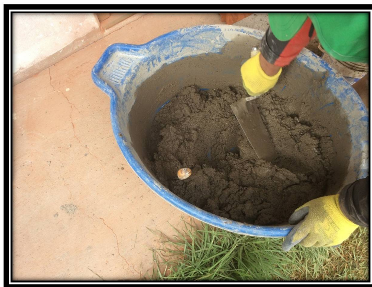
FOTOGRAFÍA N° 35: PREPARACIÓN DE MEZCLA DE MORTERO
