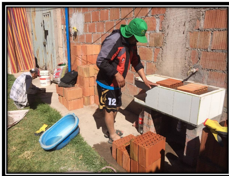
FOTOGRAFÍA N° 36: PREPARACIÓN DE LAS UNIDADES DE ALBAÑILERÍA (HUMEDECIENDO LA UNIDAD)
