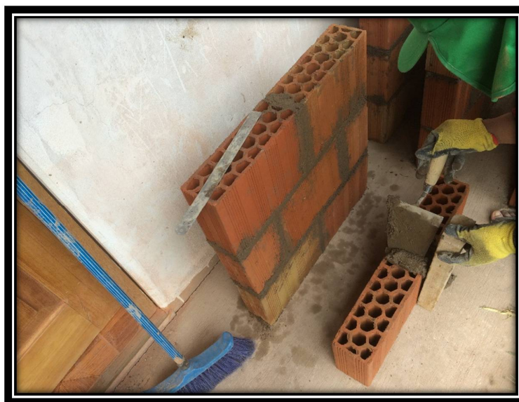
FOTOGRAFÍA N° 45: PREPARANDO LA BASE DE INICIO DEL MURETE
