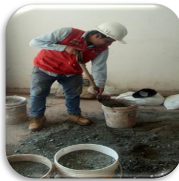
Figura 95. Muestras dosificas en palas con agregado hormigón
