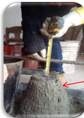
Figura 93. Verificación del slump
