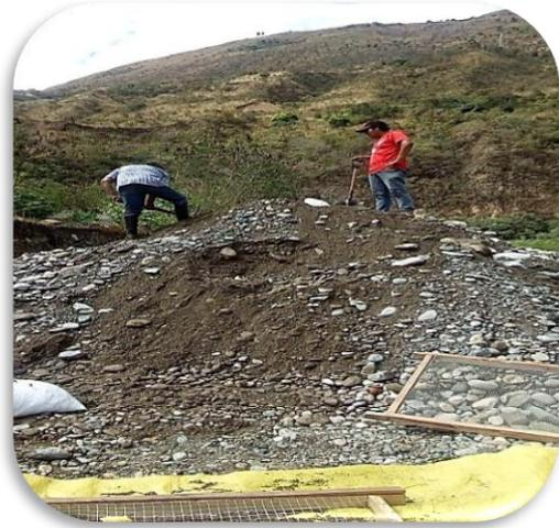
**Figura 40** . Apilamiento de agregados álveo “b” Paqcha Uchumayo
