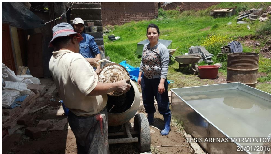
PREPARACIÓN DE MEZCLADORA Y CONTENEDORES PARA CURADO DE LAS VIGUETAS Y BRIQUETAS DE CONCRETO
