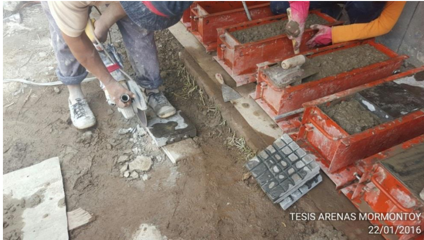
INCISIONES A LA PIEDRA LAJA PARA GARANTIZAR LA ADHERENCIA Y TRABAJABILIDAD MONOLÍTICA DE LAS VIGUETAS
