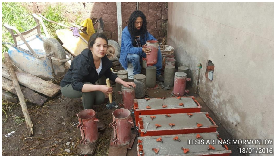
ENCOFRADO Y DEENCOFRADO DE BRIQUETAS Y VIGUETAS
