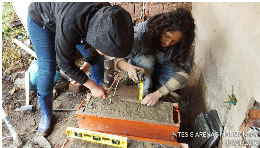
COLOCACIÓN DE LA PIEDRA LAJA EMBEBIDA EN LAS VIGUETAS DE CONCRETO
