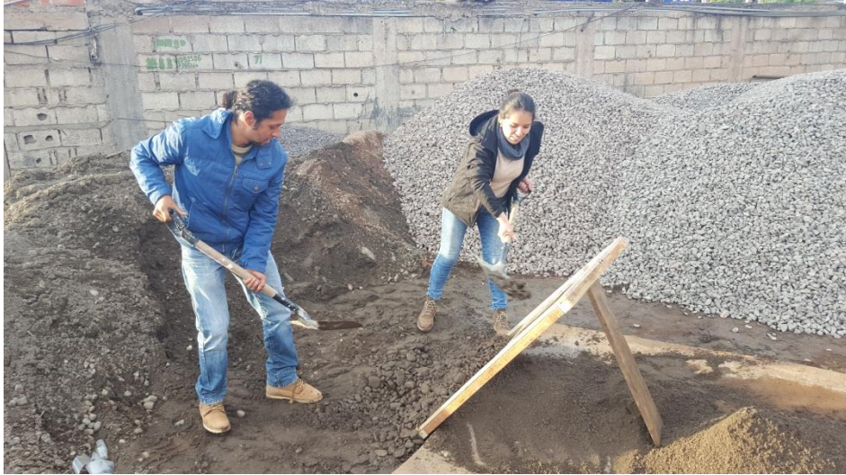
SELECCIÓN DE AGREGADO, TAMIZADO DE HORMIGÓN PARA OBTENER AGREGADO FINO
