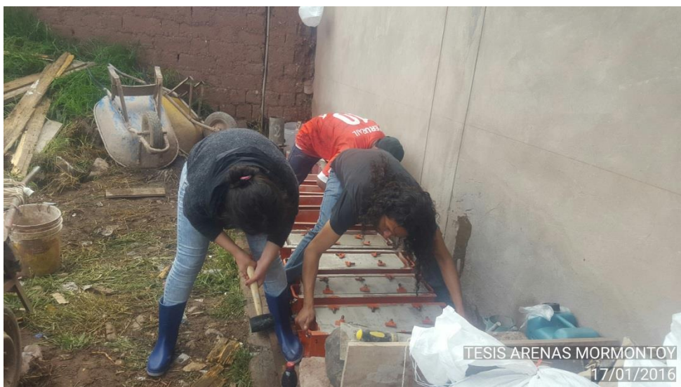
ENCOFRADO Y DESENCOFRADO DE VIGUETAS
