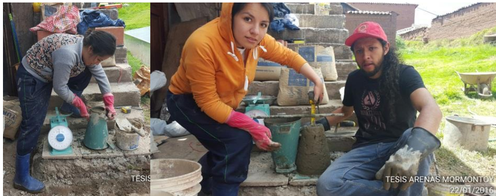
FIGURA Nº 78 PROCESO DE DESMOLDE
