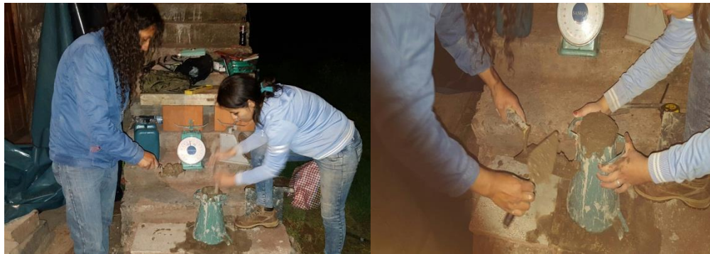
FIGURA Nº 77 VERTIMIENTO DE CONCRETO
