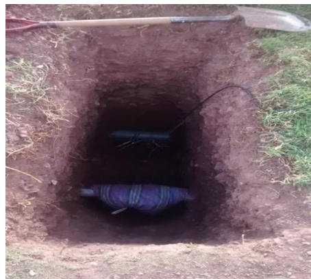
Figura N° 28: PIQUE REALIZADO PARA LA PRUEBA DE CAUDAL MÍNIMO NOCTURNO.
