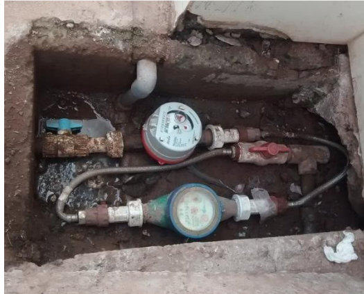
Figura N° 36: FORMA DE INSTALACIÓN DE MEDIDORES.
