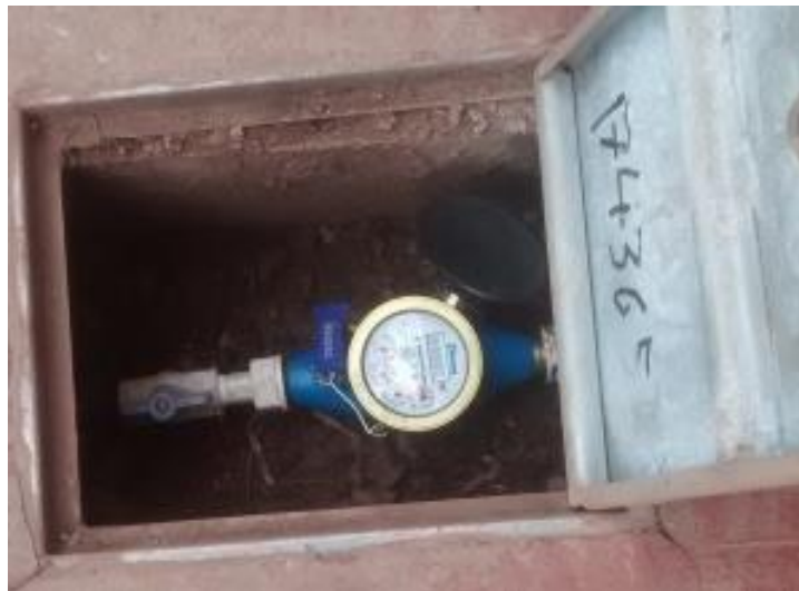
Figura N° 41: INSTALACIÓN DE MEDIDOR EN CONEXIÓN EN DIRECTO.
