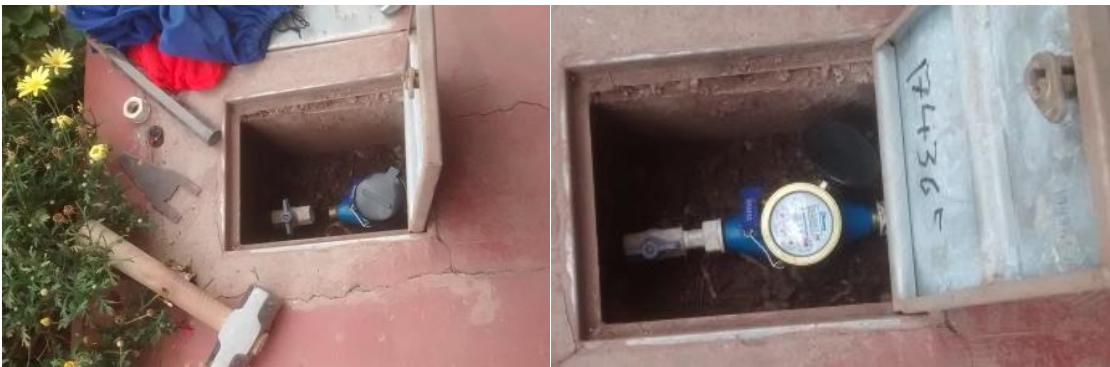
Figura N° 43: FORMA DE INSTALACIÓN DE MEDIDORES TESTIGO.
