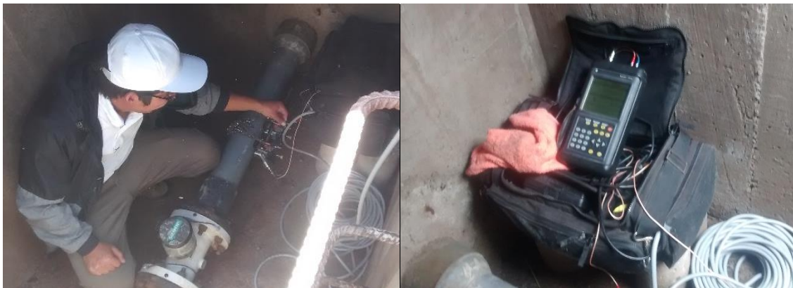
Figura N° 24: INSTALACIÓN DEL MEDIDOR DE FLUIDOS ULTRASONIDO EN LA TUBERÍA DE INGRESO DE AGUA POTABLE.
