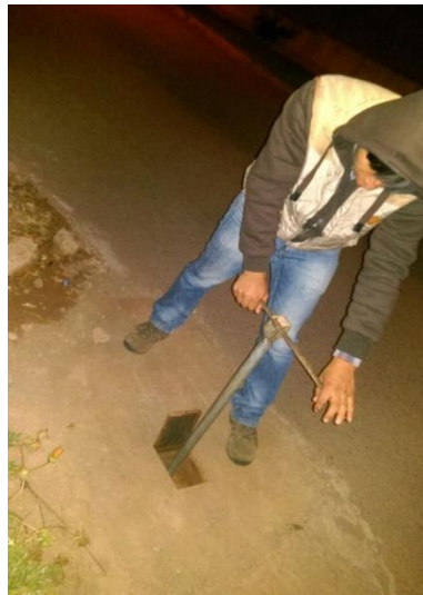
Figura N° 27: REALIZANDO LA PRUEBA DE HERMETICIDAD DE VÁLVULAS.
