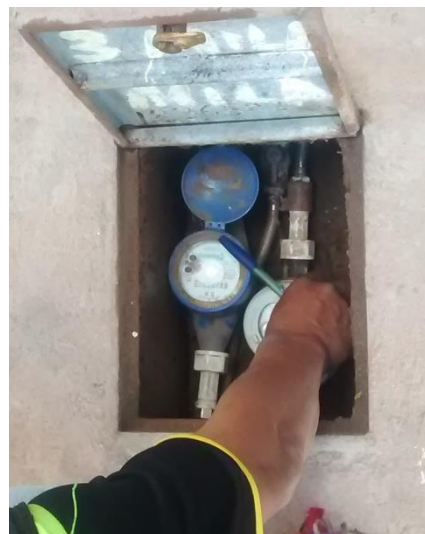
Figura N° 37: LECTURA DE MEDIDORES EXISTENTES Y MEDIDORES DE PRUEBA.
