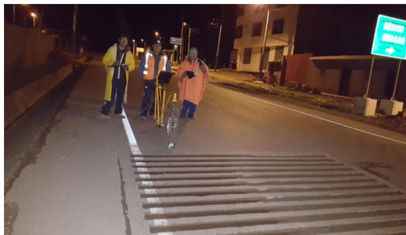
Figura 30: Bandas transversales de alerta en la carretera Cusco – Urcos (desvío Huasao).
