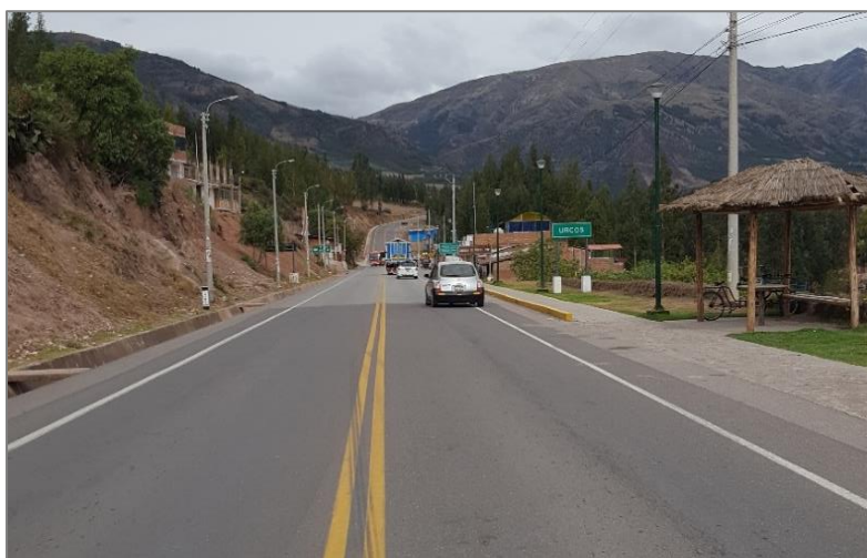
Figura 4: Pavimento flexible del tramo en estudio
