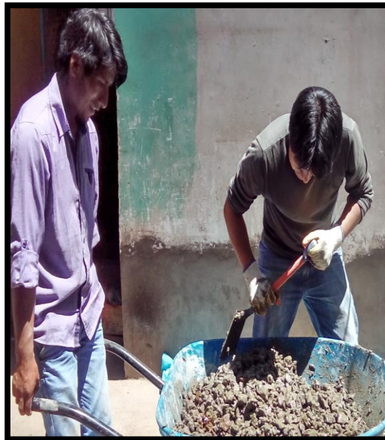
Figura 53. Mezclado manual del concreto.
