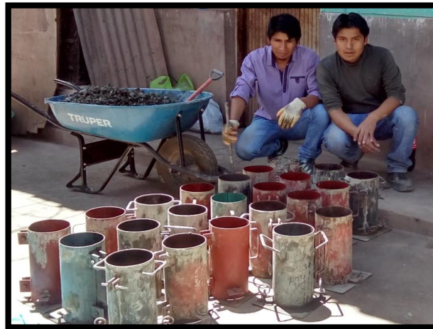
Figura 54. Moldes engrasados antes de colocar el concreto.
