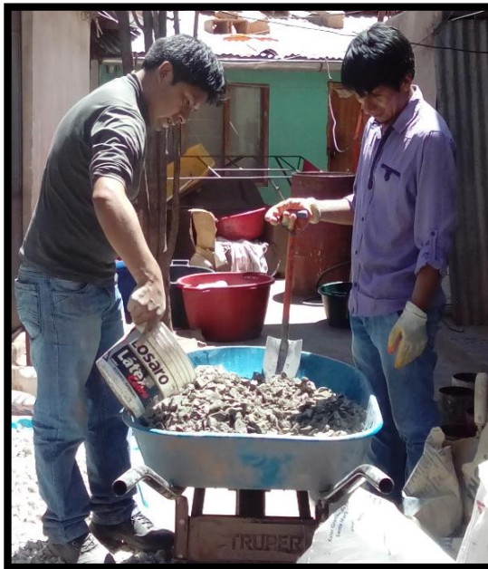
Figura 50. Suministro de agua al concreto.
