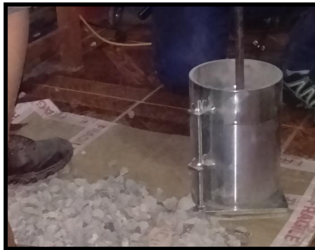
Figura 23. Apisonado del material con la varilla.
