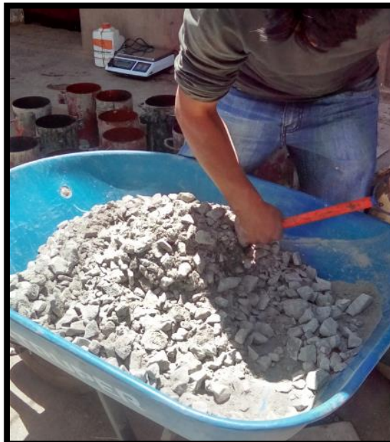
Figura 49. Mezclado del concreto.
