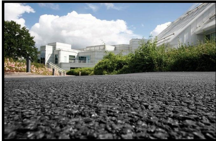
Figura 1. Pavimentos con Concreto Poroso.
