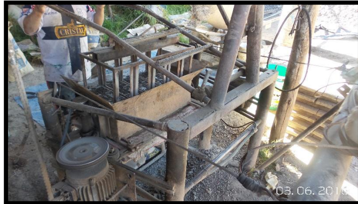
FIGURA 40: PROCESO DE COMPACTACIÓN DE LA MEZCLA
