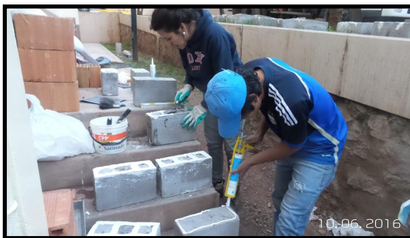
FIGURA 44: COLOCACIÓN DEL CAPPING DE CADA UNIDAD
