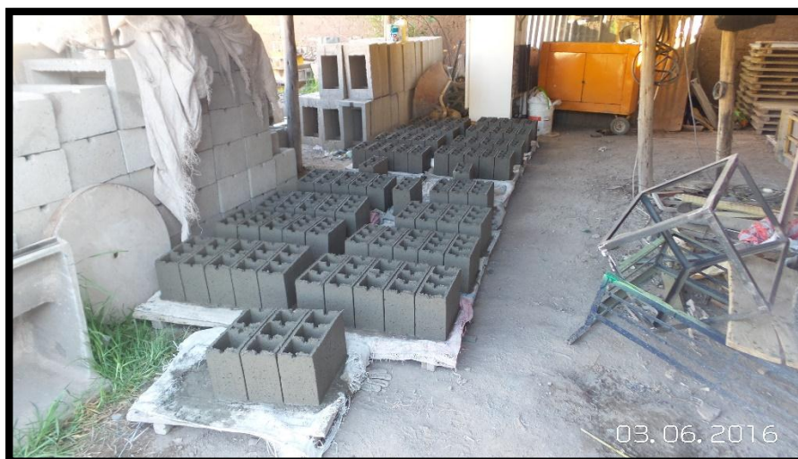
FIGURA 41: PROCESO DE FRAGUADO DE LOS BLOQUES DE CONCRETO
