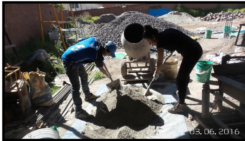
FIGURA 38: PROCESO DE MEZCLADO DE LOS AGREGADOS Y EL PET
