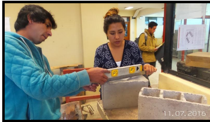
FIGURA 50: NIVELACIÓN DE LAS UNIDADES
