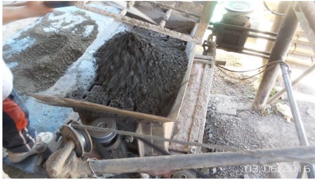
FIGURA 81: VIBRADO DE LA MEZCLA
