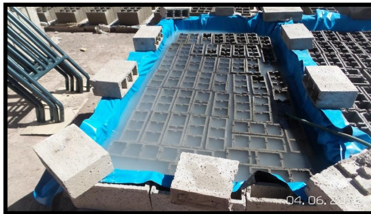
FIGURA 42: BLOQUES SUMERGIDOS EN LOS POZOS DE AGUA
