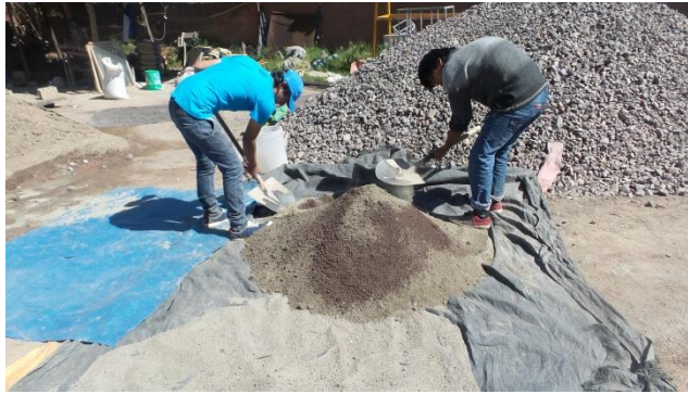
FIGURA 79: MEZCLADO DE LOS AGREGADOS DEL BLOQUE DE CONCRETO
