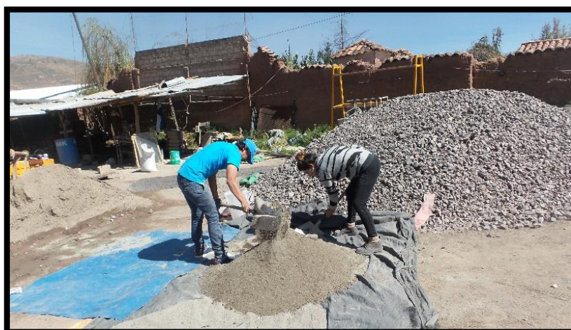
FIGURA 37: PROCESO DE MEZCLADO DE LOS AGREGADOS
