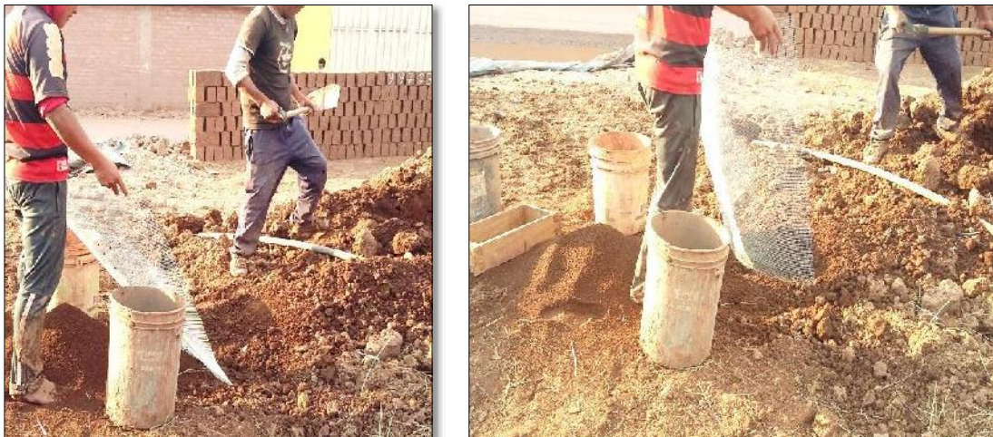
Previa la preparación del barro se tamiza la tierra con una malla metálica o zaranda de ¼” de abertura, para eliminar piedras mayores a 5mm y otros elementos extraños
