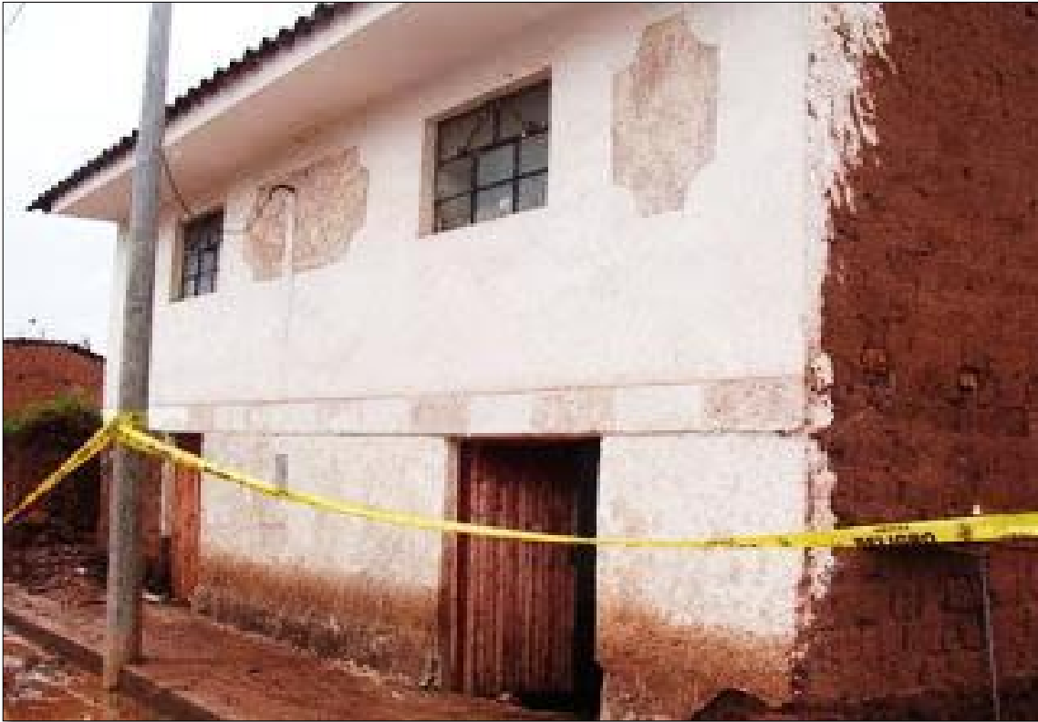
FIGURA N° 3 VIVIENDA DE ADOBE INUNDADA POR DESBORDE DE RIO EN IZCUCHACA – ANTA.
