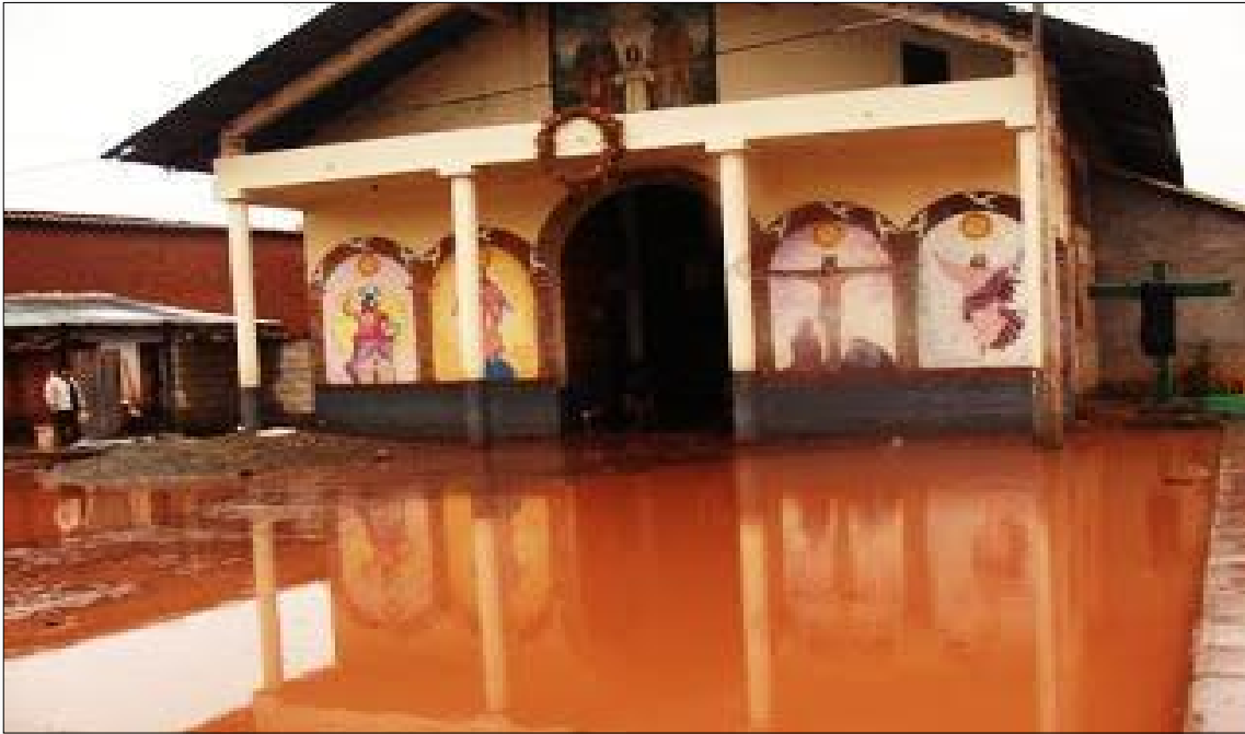
FIGURA N° 4 IGLESIA DE ADOBE INUNDADA POR DESBORDE DE RIO EN IZCUCHACA – ANTA.
