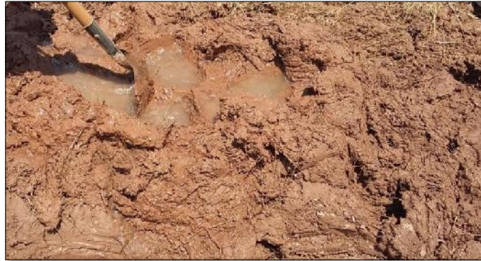
FIGURA N° 42 HIDRATACIÓN DE LA TIERRA PREVIA LA PREPARACIÓN DEL BARRO
