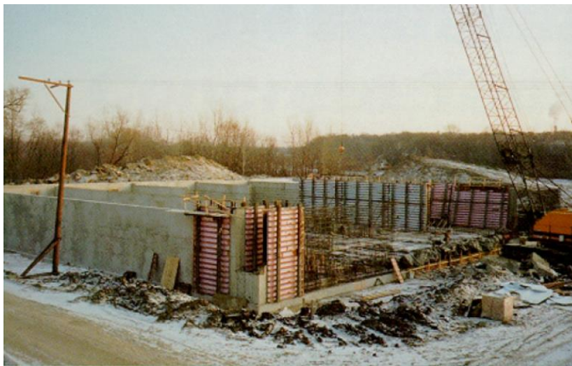
Figura 3: Tanque rectangular de concreto
