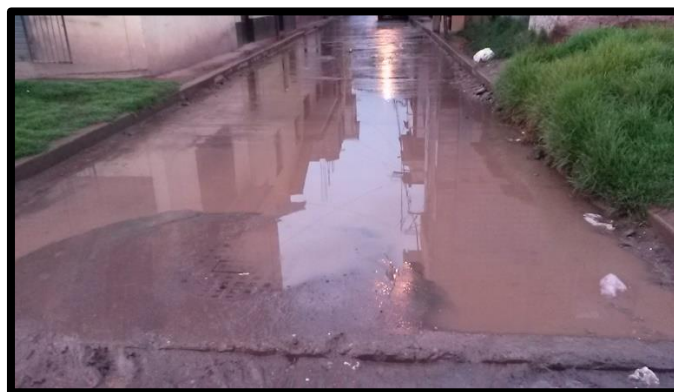
Figura N° 1: Empozamiento de aguas en la calle Prolongación Sucre
