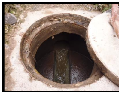
Figura N° 24: Inspección de buzón dentro del Sistema de Aguas Residuales - APVs 28 de Julio, Kantu, Villa Mercedes y Vista Alegre
