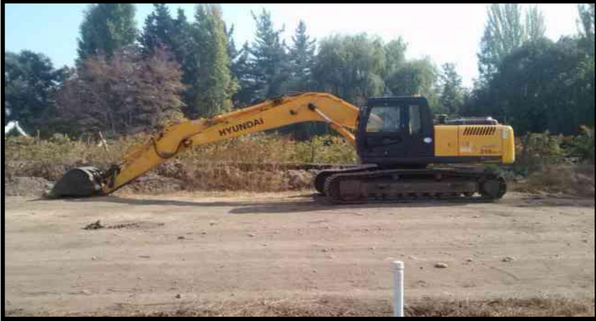
EXCAVADORA ANTES DE INICIAR EL TRABAJO
