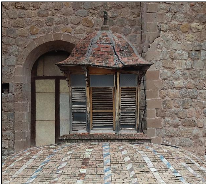
Figura 71: Detalle de la linterna sobre la cúpula de la Capilla Loreto
