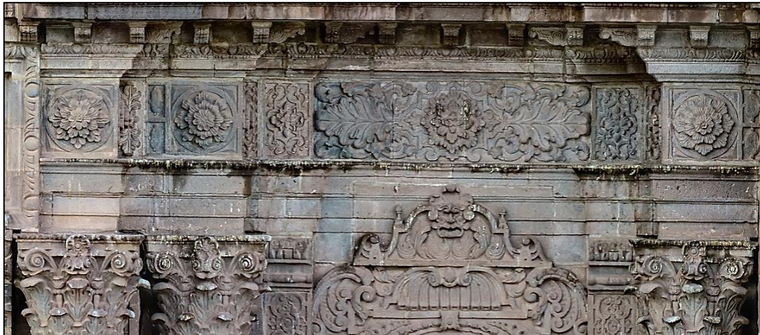
Figura 58: Detalle del friso ornamentado con rosetas y el arquitrabe de tres platabandas
