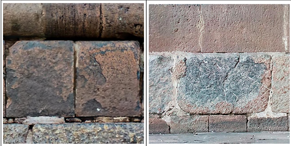
Figura 103: Exfoliación presente en el lateral de la Torre del Evangelio.
