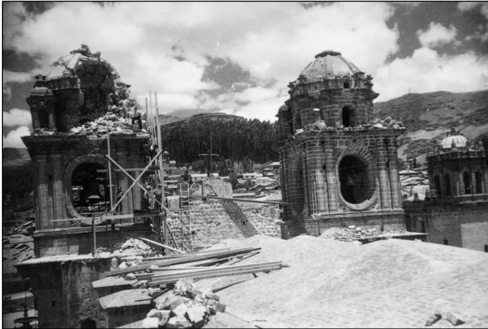
Figura 39: Desplome de las torres campanario del Templo de la Compañía de Jesús ocasionadas por el terremoto de 1950.
