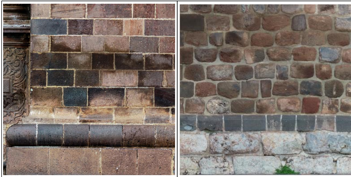
Figura 101: Alteración presente en el basamento de la Torre de la Epístola y en la parte inferior de la calle Loreto
