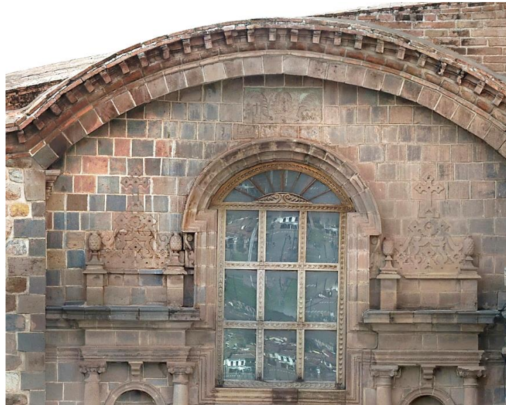
Figura 66: Detalle del vano de medio punto y remate de la fachada de la Capilla Loreto
