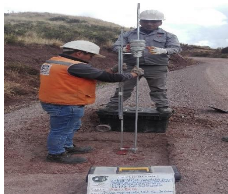
Figura N°66.- Colocación del instrumento PDC en el suelo.
