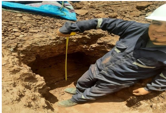
Figura N°36.- Excavación de la calicata N°-03, km 14.125 de la carretera Conchacalla abra Occoruro.
