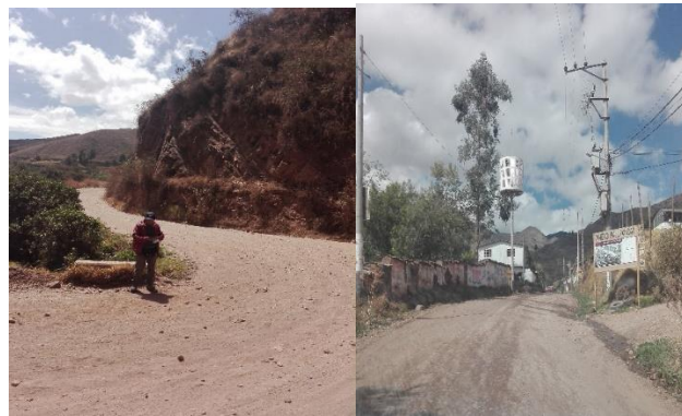
Figura N°1.- Condiciones Actuales de la Carretera.
