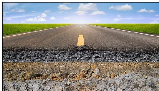
Figura N°5.- Estructura de Pavimento mostrando la subrasante.
