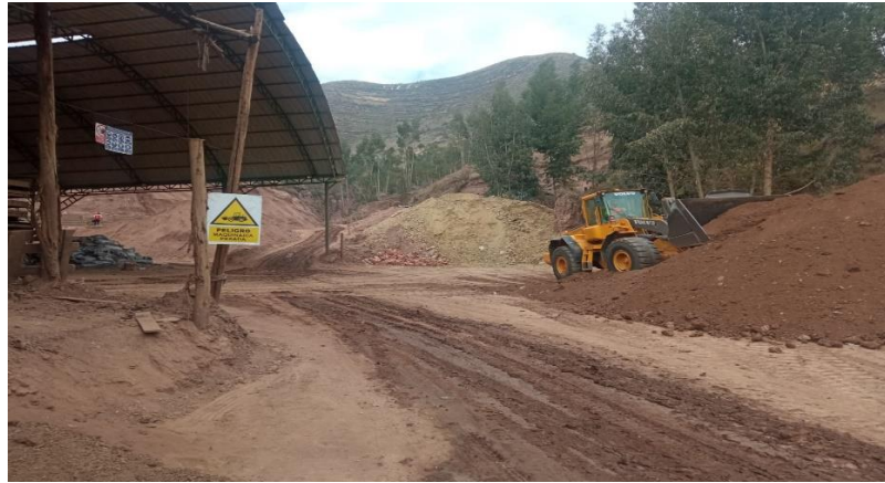
Figura 69 Preparación de la materia prima con cargador frontal.
