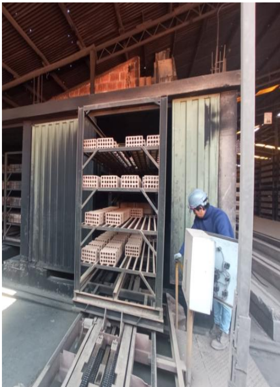
Figura 152 Colocación al horno de la U. de Albañilería.
