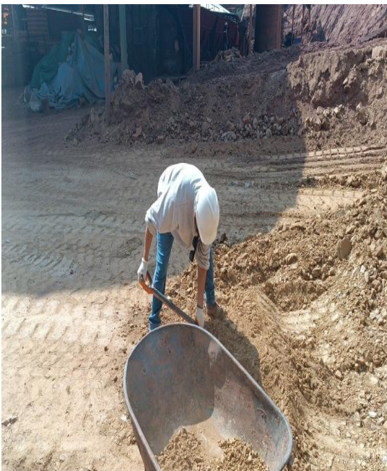
Figura 145 Preparado para zarandeo.
