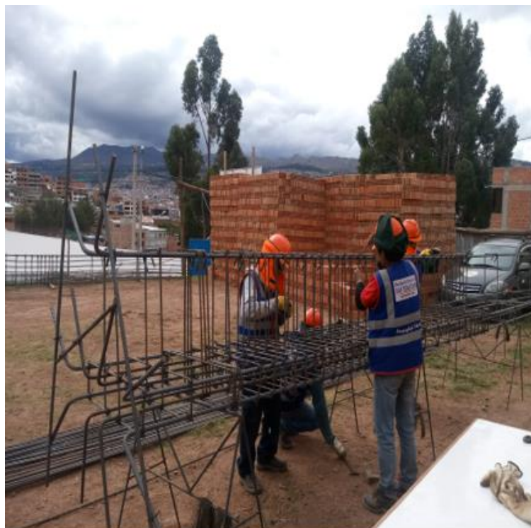
Acero grado 60 en columnas y placas
