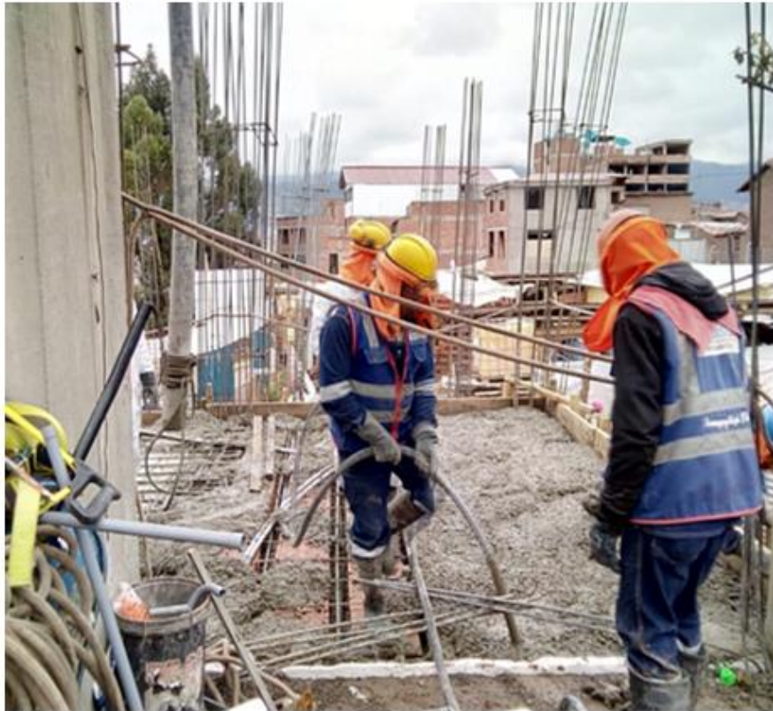
Concreto f_c=210\text{kg/cm}^2 en losa aligerada
