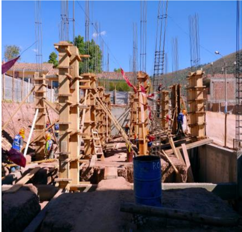
Encofrado y desencofrado de columnas y placas
