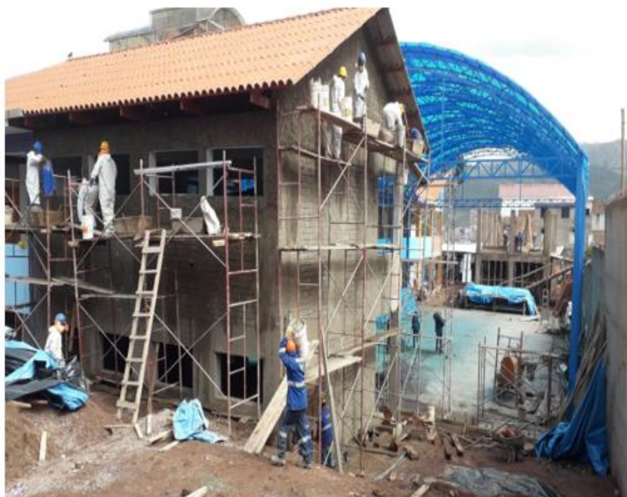
Revoques y revestimientos
