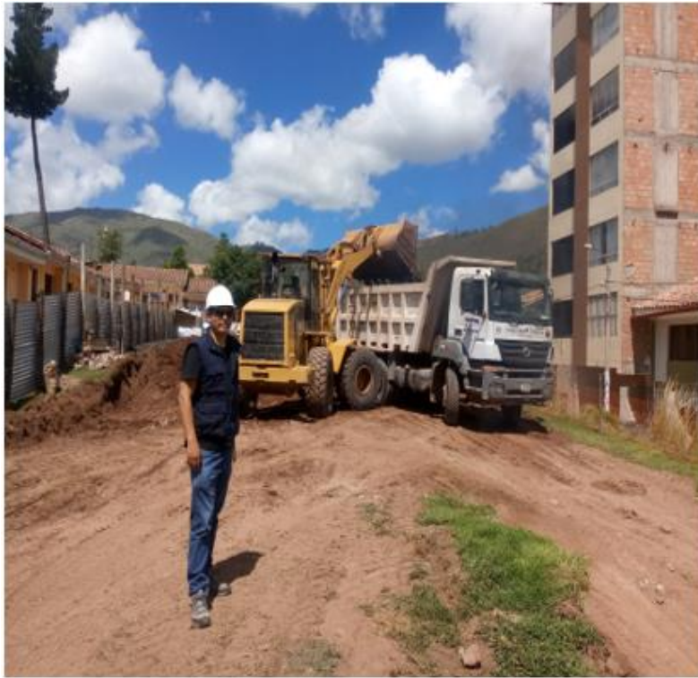
Eliminación de material excedente con maquinaria d=15 km.
