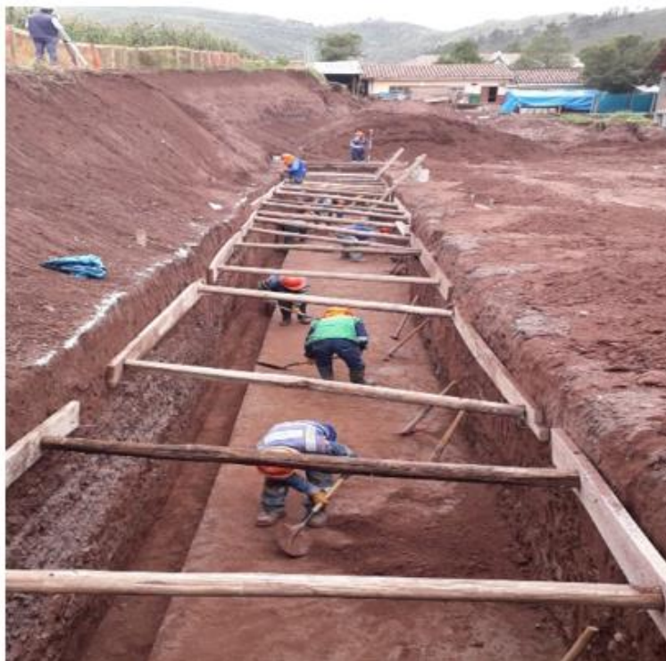
Entibado y tablaestacado continuo
