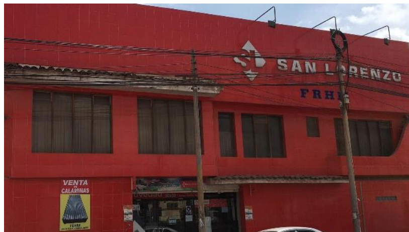
Figura 13. Fachada de F.R.H.M.
