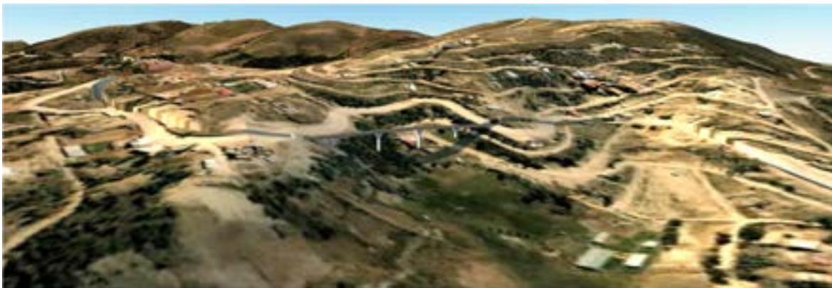
Figura 87 Pase a desnivel en Km 11+250
