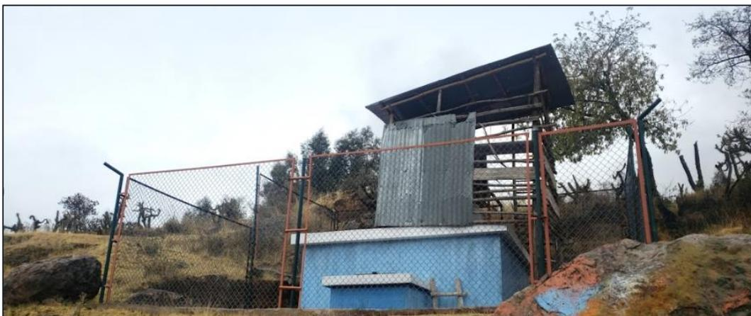
El tanque de almacenamiento presenta un volumen de 5 m<sup>3</sup>, diseñado el año 2013 conforme a la demanda promedio de agua, así como, la frecuencia de suministro, en la parte superior presenta una tapa (compuerta de acceso) para la limpieza y mantenimiento del interior de la estructura, de igual manera, la tubería de ventilación del aire con la curvatura hacia abajo.
