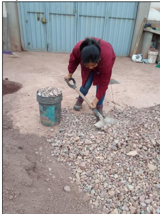
Figura 107. Peso de los agregados por tanda
