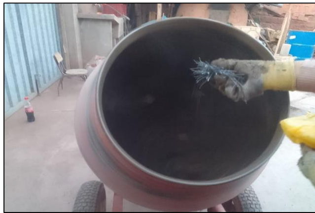
Figura 109. Colocación de las fibras metálicas Wirand FF1
