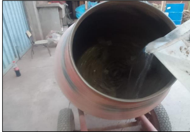
Figura 108. Colocación de agua en la mezcladora
