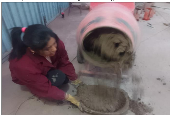
Figura 110. Vaciado de mezcla para un concreto f'c=280 \text{ kg/cm}^2
