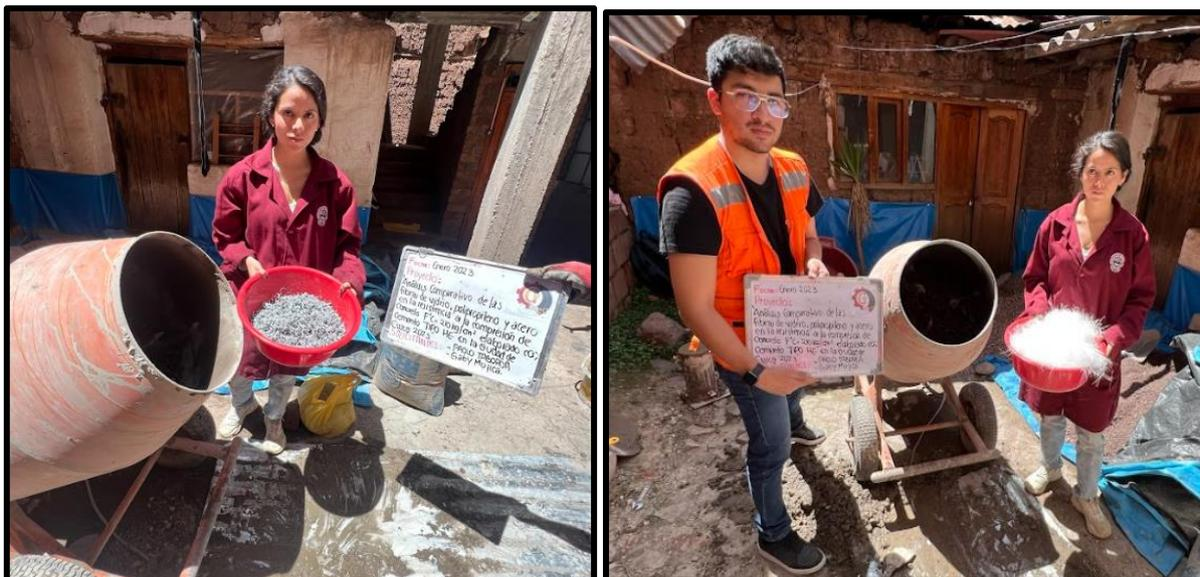
*Nota.* Aplicación de las fibras en el mezclado del concreto.
