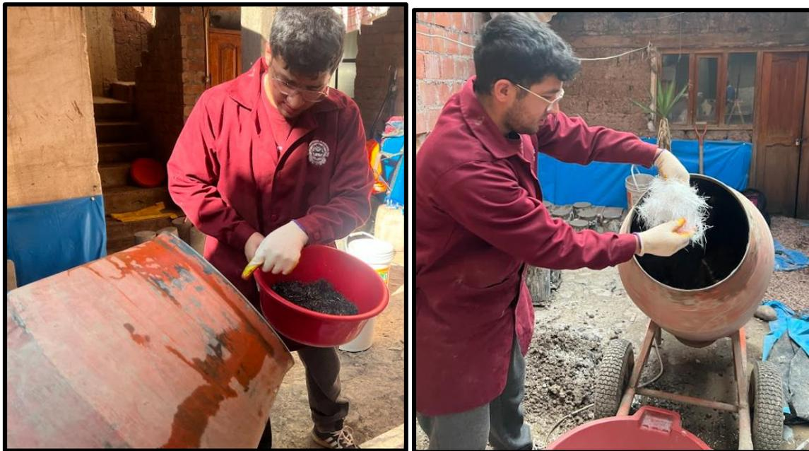
*Nota.* Aplicación de las fibras en el mezclado del concreto.
