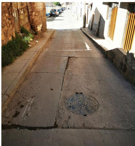
*Ilustración 23- Buzón de Inspección - Línea Umachata
