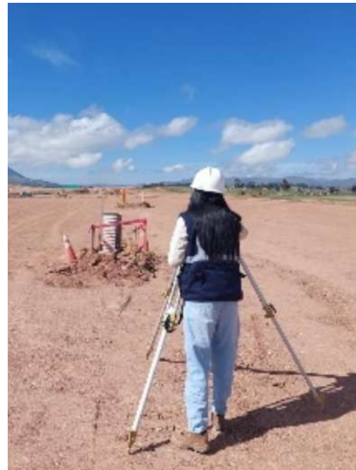
Figura 159 Monitoreo placa de asentamiento Sector T4-E-1
