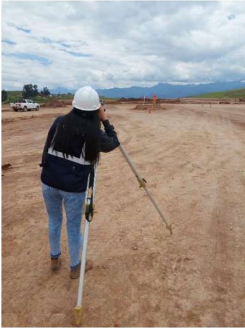
Figura 157 Monitoreo placa de asentamiento Sector T4-T-3
