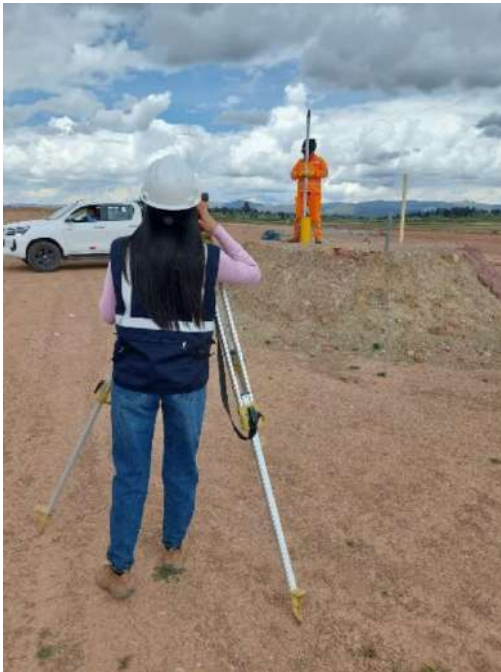
Figura 172 Monitoreo placa de asentamiento Sector T8-R
