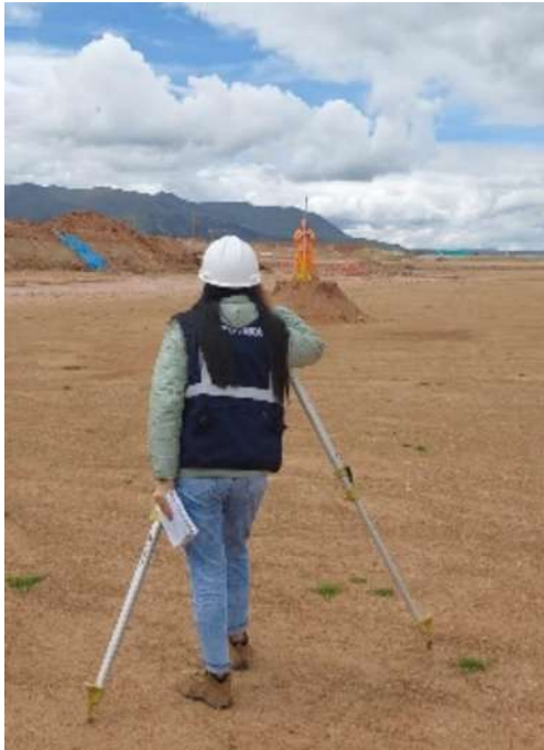
Figura 151 Monitoreo placa de asentamiento Sector T7-RD
