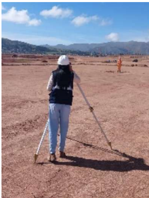
Figura 145 Monitoreo placa de asentamiento Sector T6-RD-3
