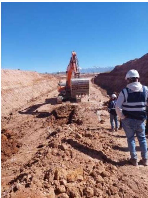
Figura 192 Retiro de precarga en sectores
