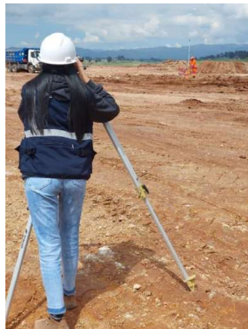
Figura 146 Monitoreo placa de asentamiento Sector T6-RD-4
