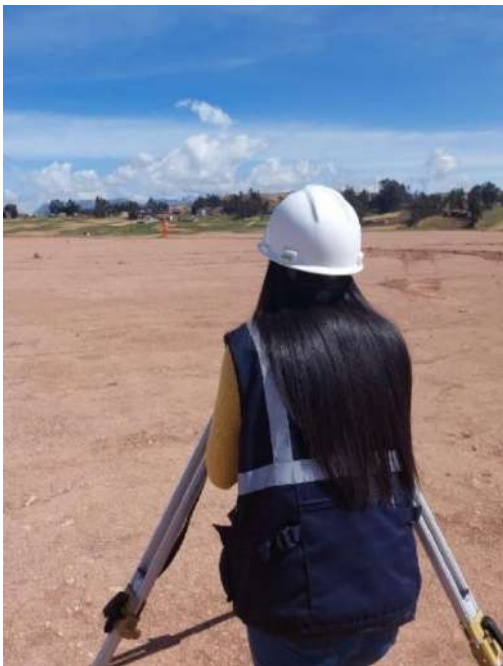
Figura 187 Monitoreo placa de asentamiento Sector T1-F
