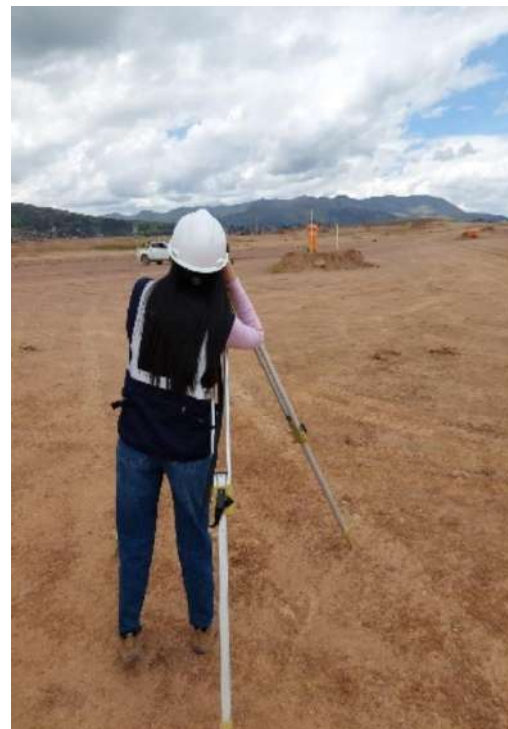
Figura 179 Monitoreo placa de asentamiento Sector T4-E-2
