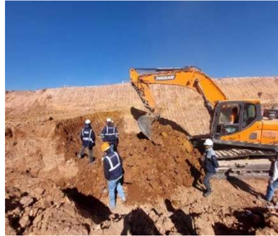
Figura 189 Retiro de precarga
