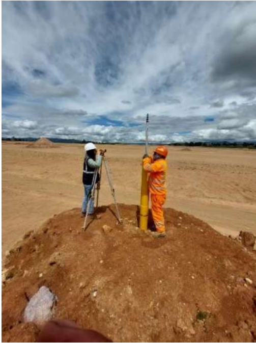
Figura 183 Monitoreo placa de asentamiento Sector T4-E-3
