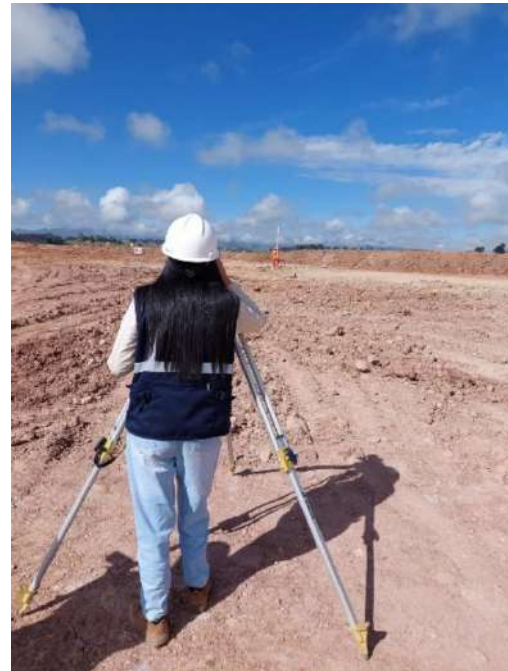
Figura 147 Monitoreo placa de asentamiento Sector T6-RD-2
