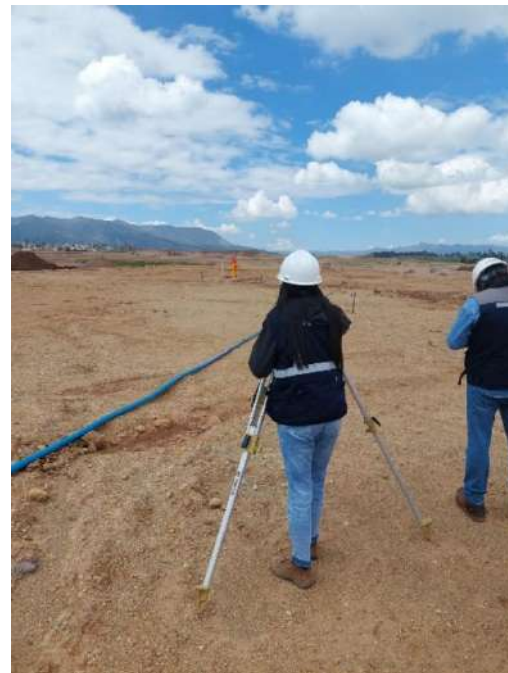
Figura 155 Monitoreo placa de asentamiento Sector T3-T-2
