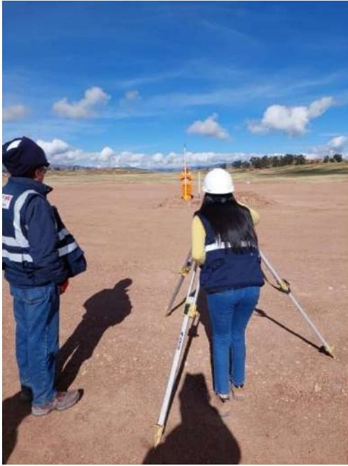
Figura 190 Monitoreo placa de asentamiento Sector T6-RD-5
