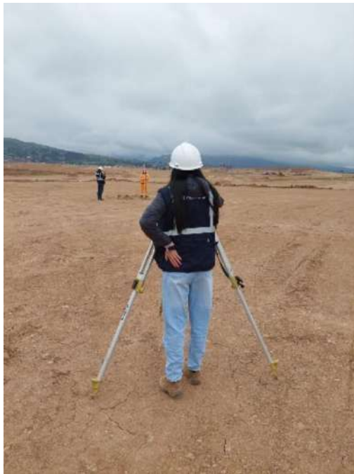
Figura 148 Monitoreo placa de asentamiento Sector T6-RD-1
