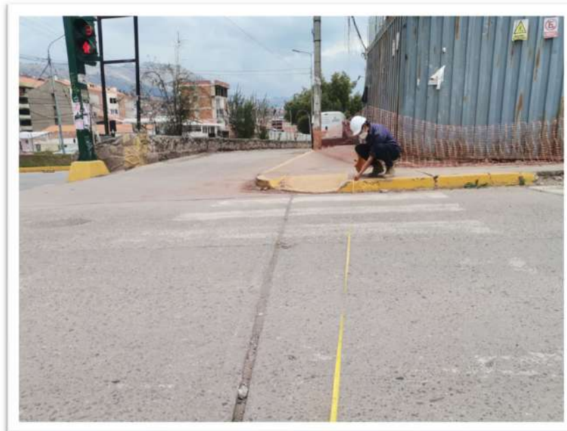
TOMA DE MEDIDAS ADICIONALES DE ANCHO DE VÍA A LO LARGO DE LA AV. LA CULTURA Y SUS INTERSECCIONES.
