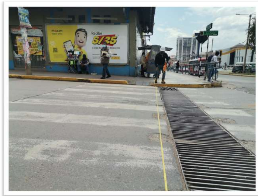
TOMA DE MEDIDAS ADICIONALES DE ANCHO DE VÍA A LO LARGO DE LA AV. LA CULTURA Y SUS INTERSECCIONES.
