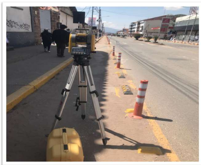
PUNTO DE ESTACIÓN EN AV. LA CULTURA CON AV. HUASCAR, INICIO DEL LEVANTAMIENTO TOPOGRÁFICO.
