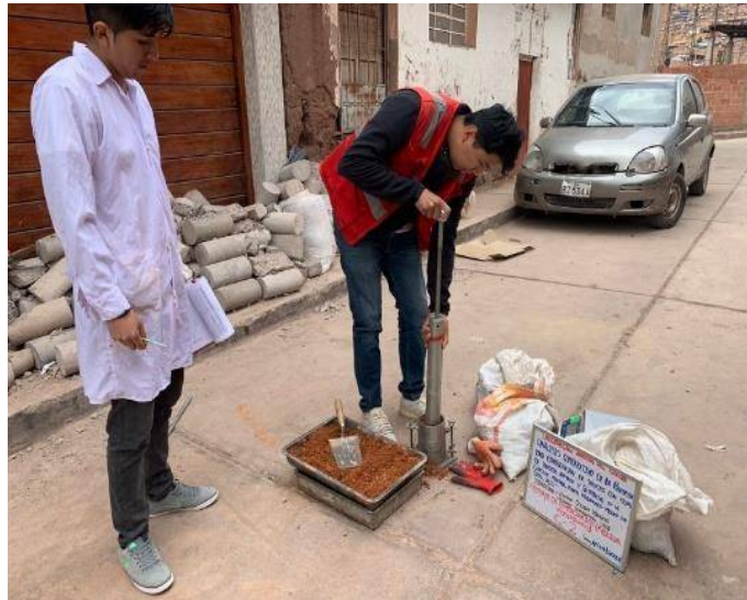
Figura 93: Realización de golpes sobre el molde.
