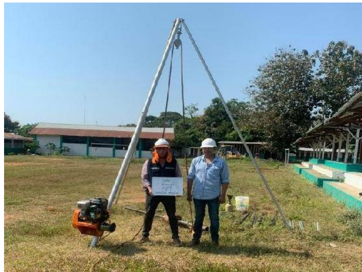
Figura 44: Ensayo SPT in situ.
