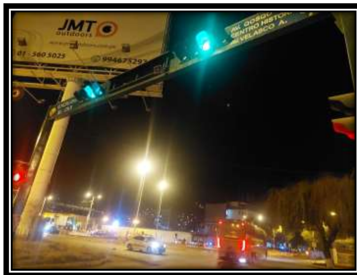
Figura 62: Dispositivos de Control. Av. Velazco Astete c/. Ov. Libertadores.
