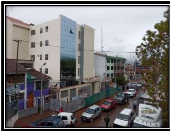
Figura 67: Centro de Salud en Construcción. Av. 28 de Julio.
