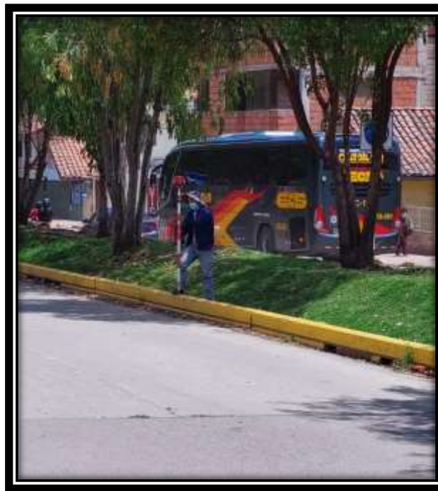
Figura 74: Toma de Puntos del Levantamiento Topográfico.
