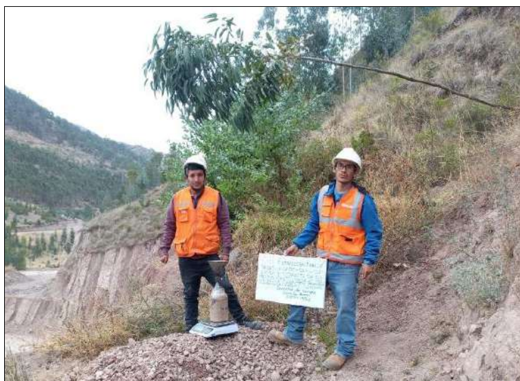
Figura 77: Cono de arena pesado después del ensayo
