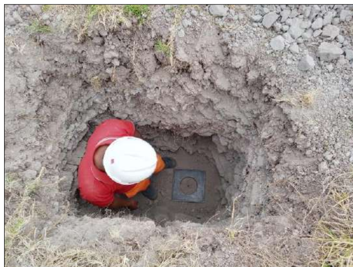
Figura 73: Colocación del plato base en el fondo de la calicata
