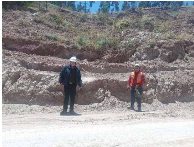
Figura 31: Ubicación de la posible Línea de Falla
