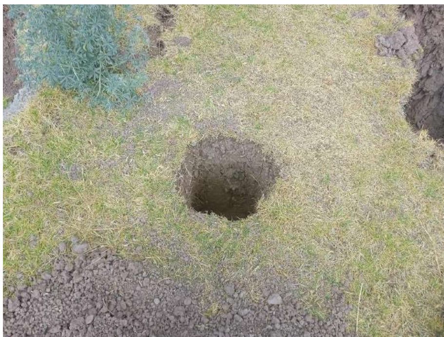
Figura 85: Excavación de agujeros de 23cm de diámetro y 55cm de profundidad
