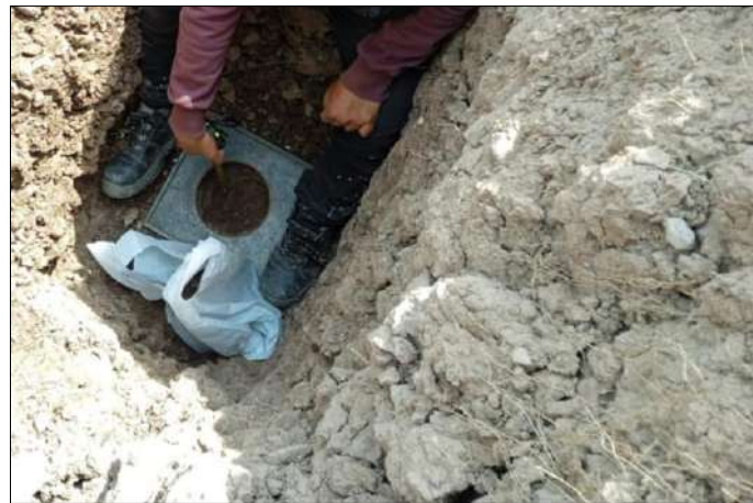
Figura 74: Excavación del hoyo y medición de su altura
