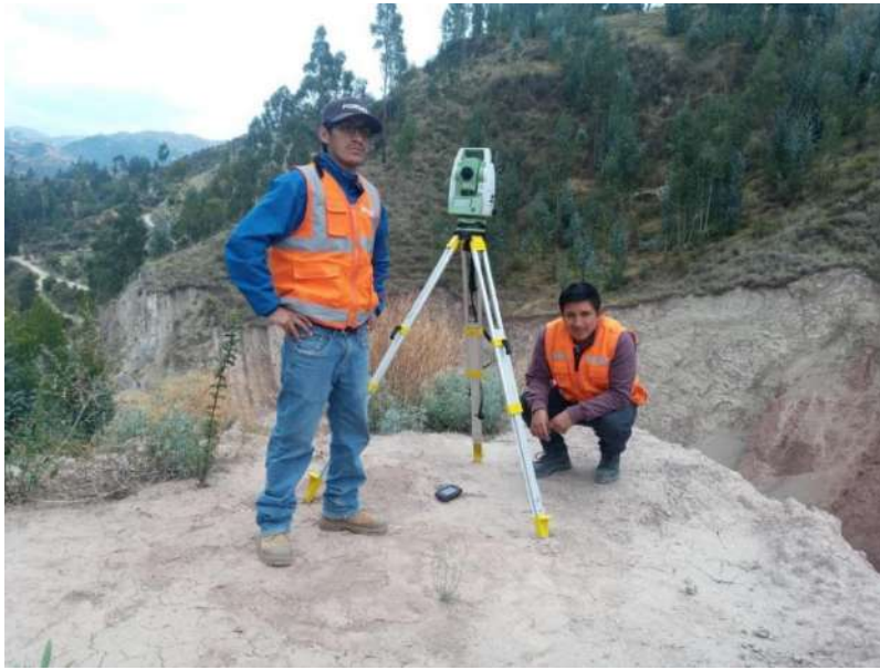
Figura 34: Estacionamiento o montaje del equipo
