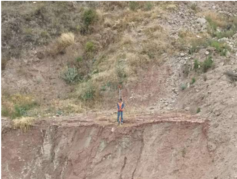
Figura 35: Posicionamiento del prisma para el levantamiento
