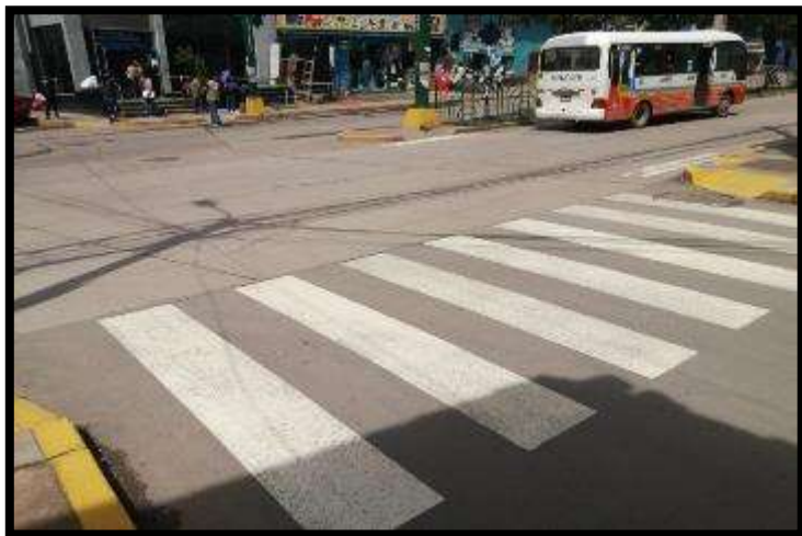
Señal horizontal de paso peatonal
