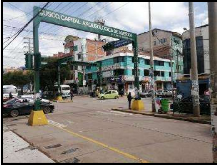
Sistema semaforizado existente
