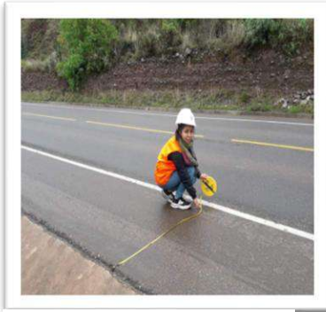
Figura 52. Medición del sobrecancho de la vía
