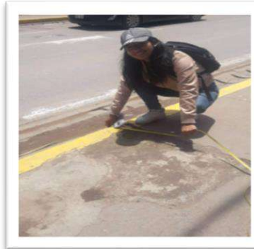
Figura 53. Medición del ancho de la berma
