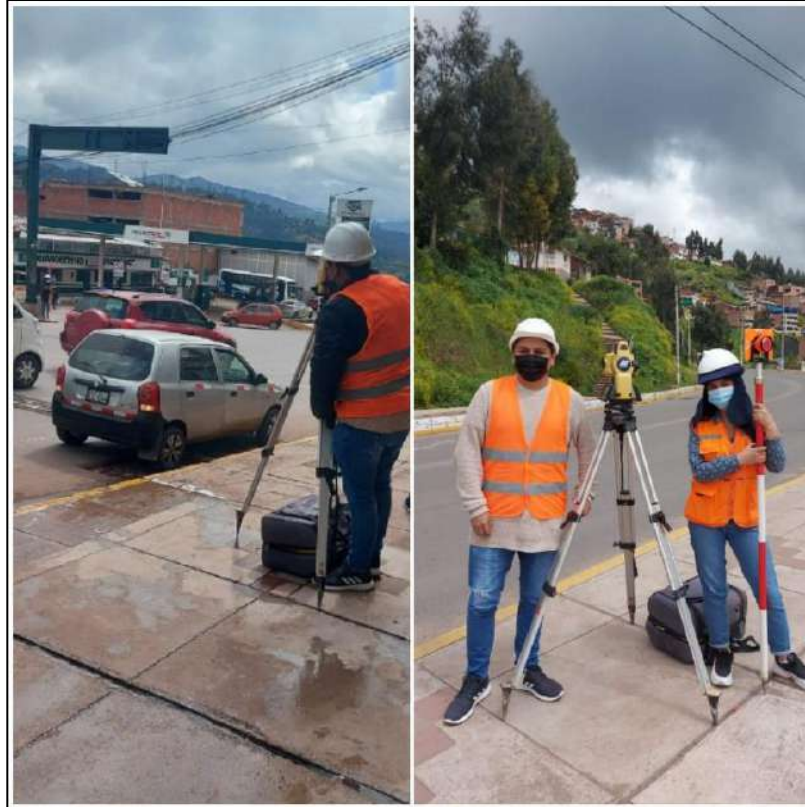
Figura 40. Fotos de levantamiento topográfico.
