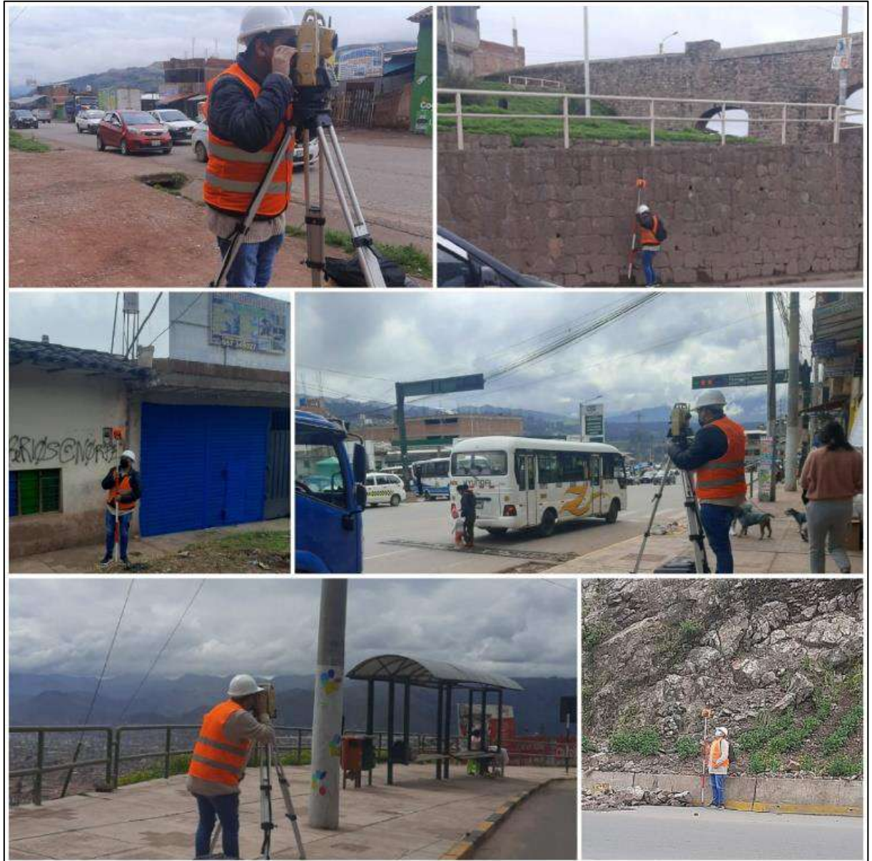
Figura 41. Fotos de levantamiento topográfico.
