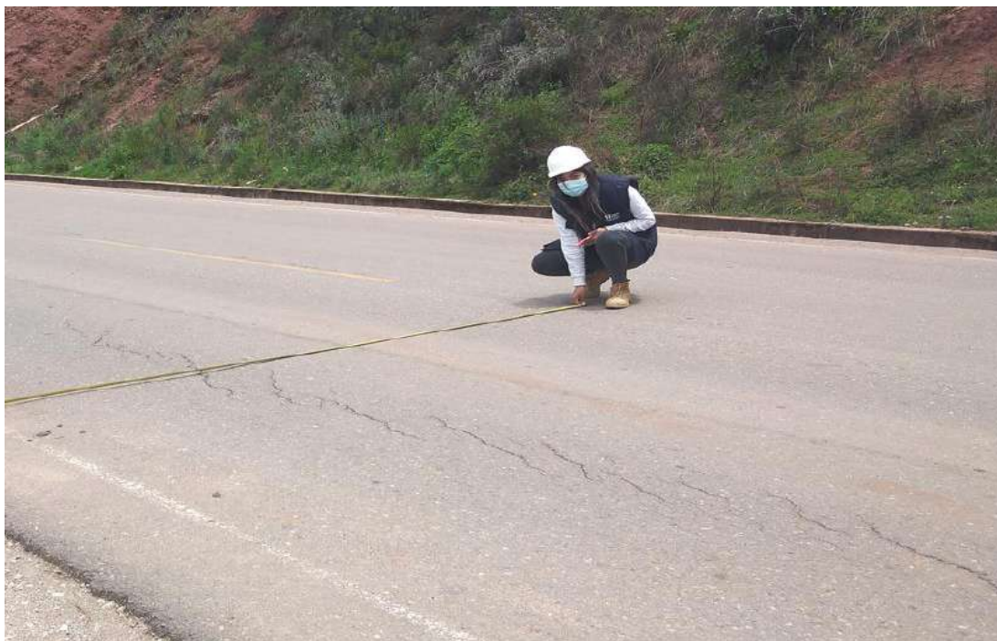
Figura N°29: toma de medidas del carril de subida tramo I
