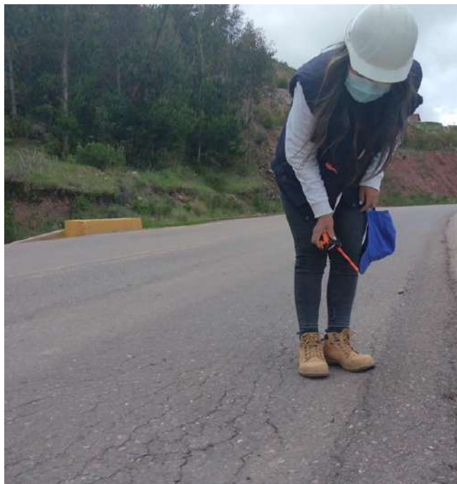
Figura N°28: Verificación estado del pavimento en la carretera
