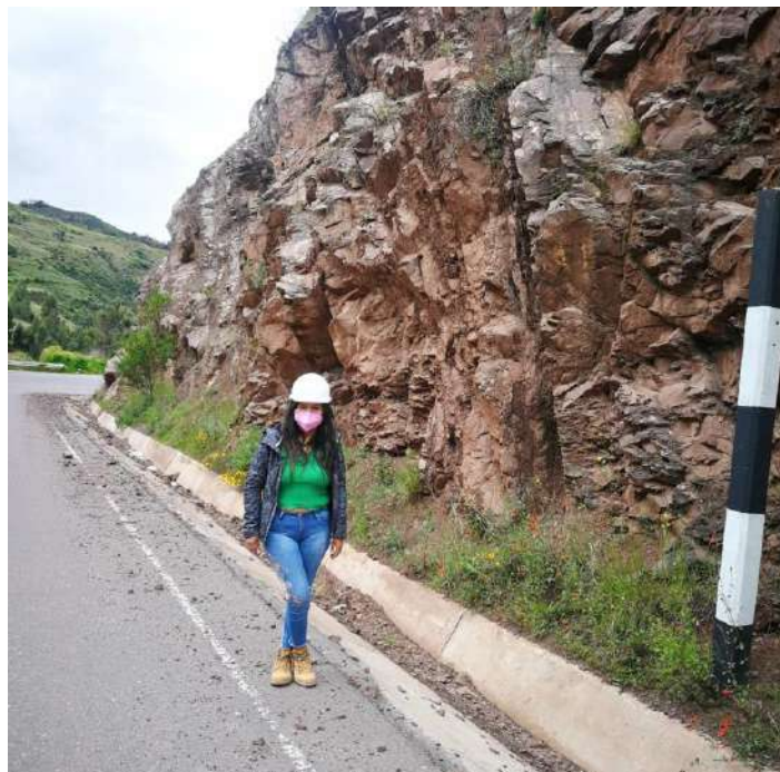
Figura N°27: Verificación zonas de desprendimientos en la carretera
