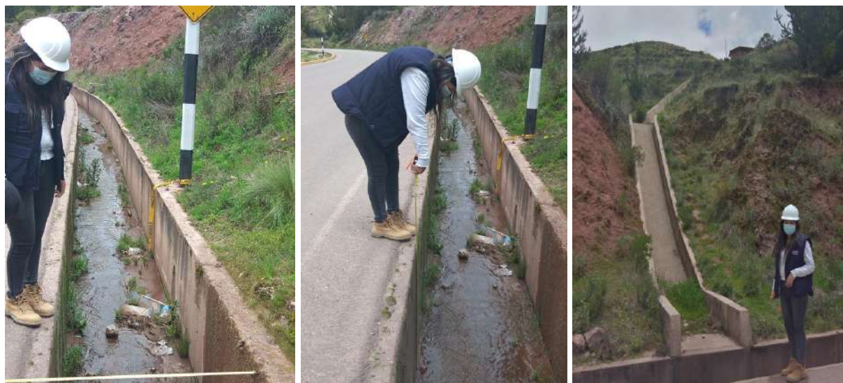
Figura N°34: Toma de medidas canaletas
