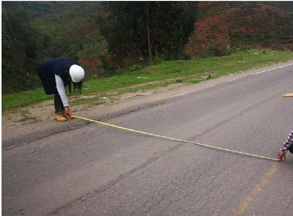
Figura N°31: toma de medidas del carril de subida tramo II
