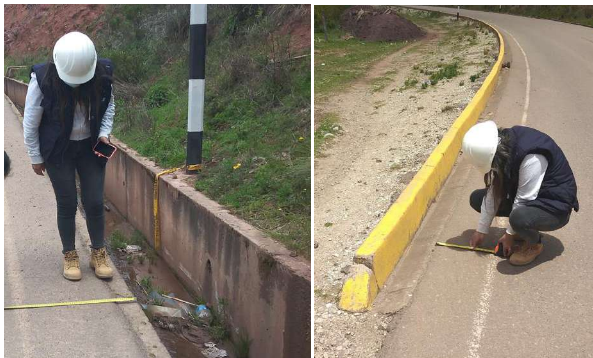
Figura N°33: Toma de medidas ancho de la berma
