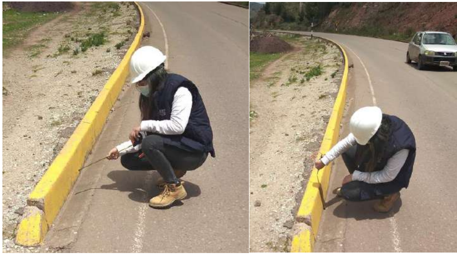
Figura N°35: Toma de medidas cunetas
