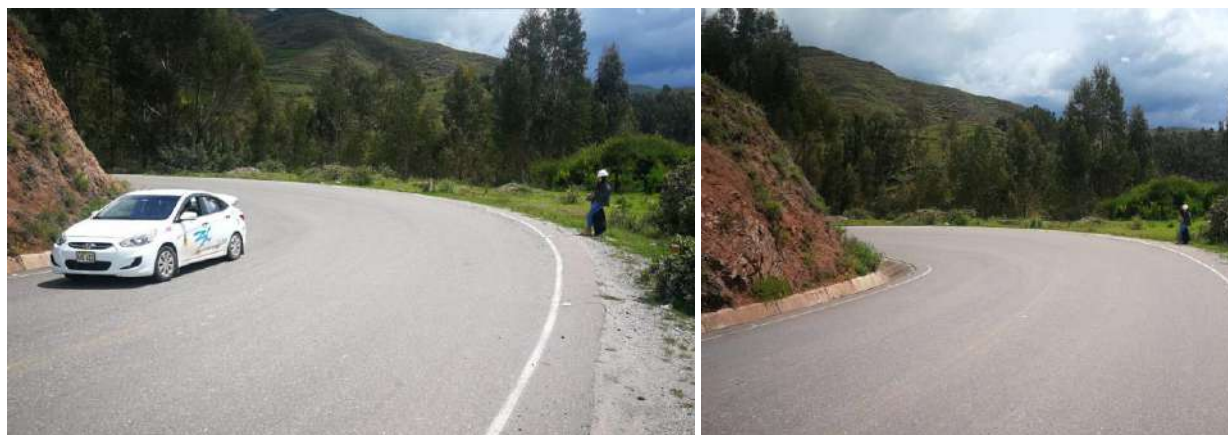
Figura N°24: Aforo tramo II
