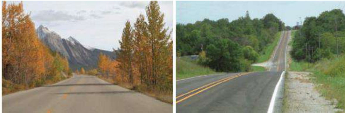
Figura N°9: Ejemplo de carreteras de dos carriles de Clase-II
