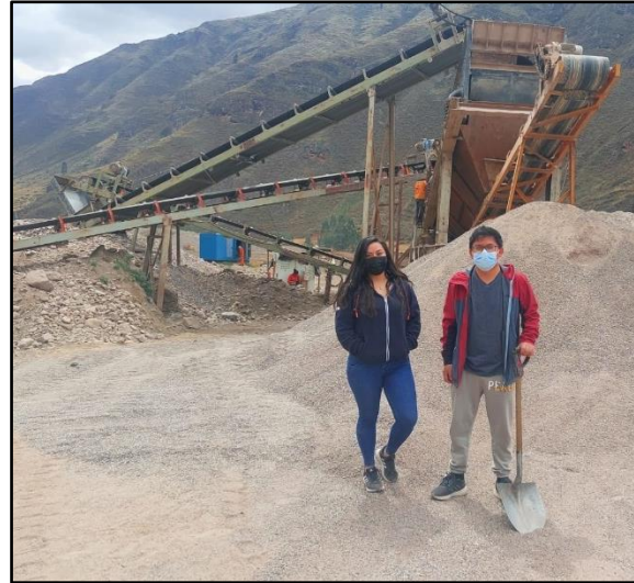
Figura 145: Agregado de cantera de Morro Blanco
