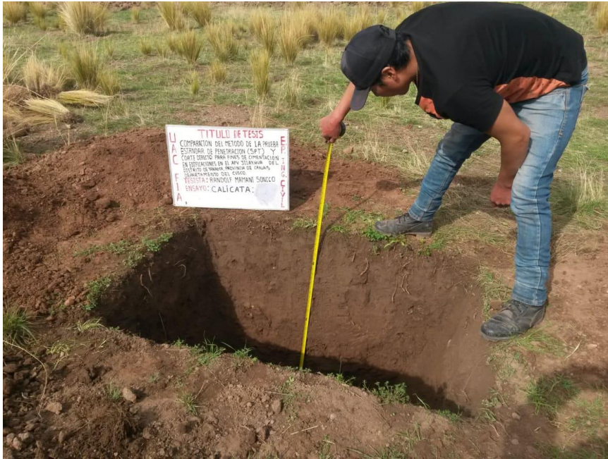
Excavación de calicata N°05
