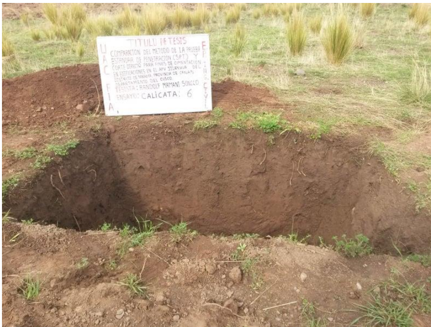
Excavación de calicata N°06
