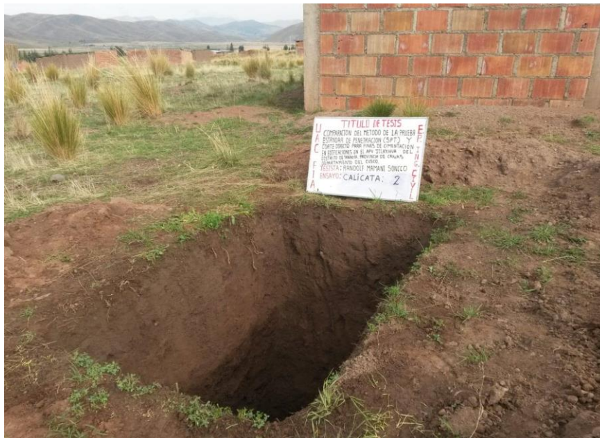
Excavación de calicata N°02
