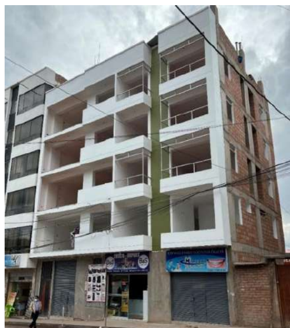
Vista Externa de la Vivienda Multifamiliar de Concreto Armado de 5 Niveles
