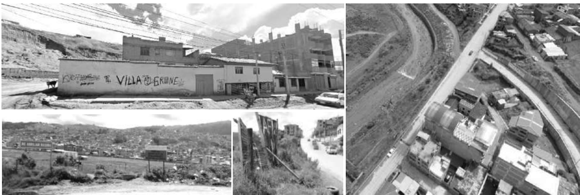
Figura 3: Collage de imágenes / Pequeña Fracción del Sector Av. Costanera APV Munay
