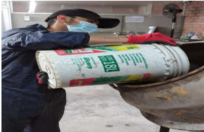
Figura 69. Colocación del cemento en la mezcladora.
