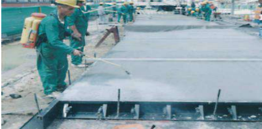
Figura 22. Aplicación de un compuesto de curado por aspersión
