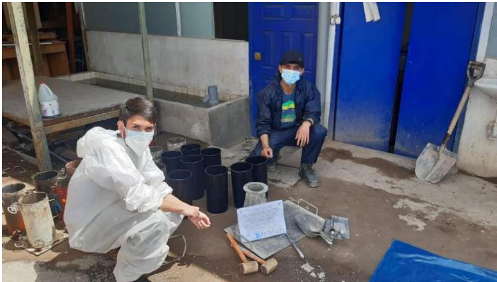
Figura 60. Verificación del Estado de los equipos y materiales a utilizar para el vaciado.
