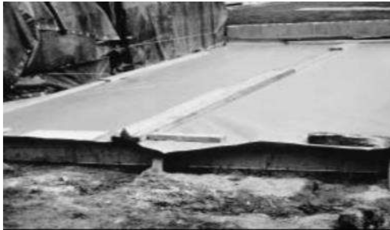
Figura 23. Losa cubierta con láminas plásticas (lonas) impermeables para curado
