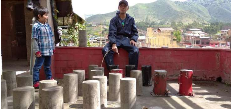
Figura 82. Desencofrado de las Probetas de concreto tras 24h de haber realizado el vaciado.
