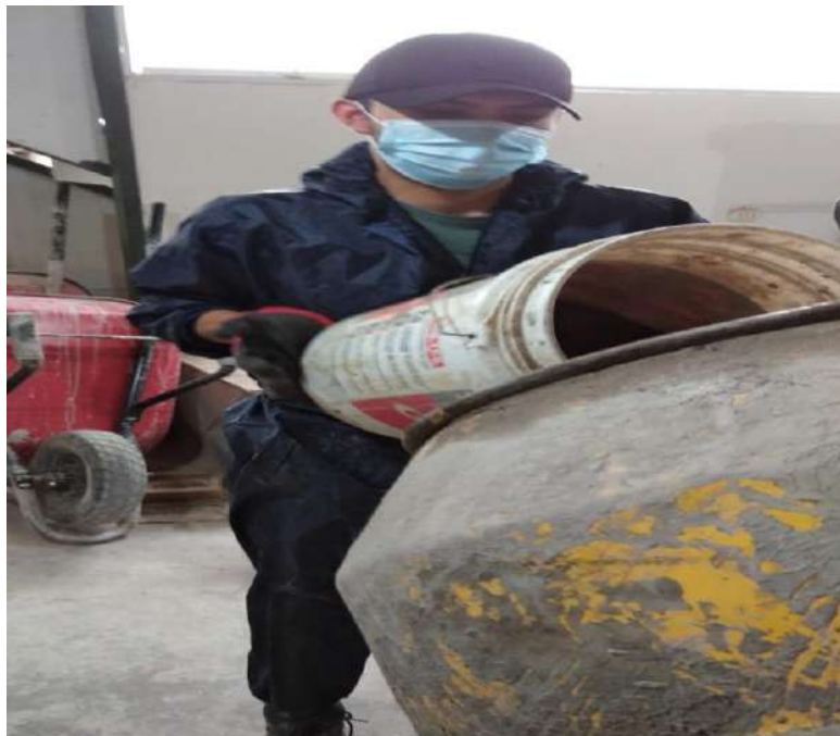
Figura 68. Colocación de agua en la mezcladora.
