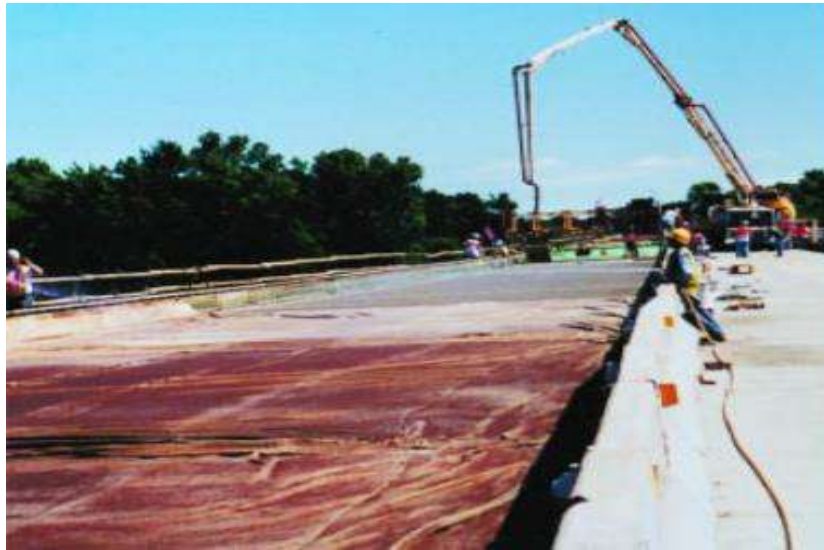
Figura 20. El curado debe empezar en cuanto el concreto se endurezca suficientemente para prevenir la erosión de la superficie
