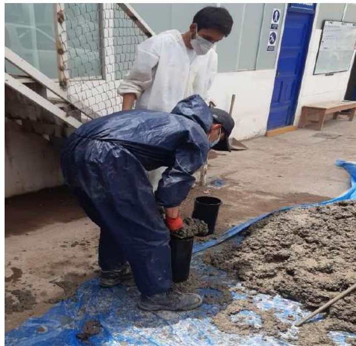
Figura 79. Colocación del concreto en las briqueteras.
