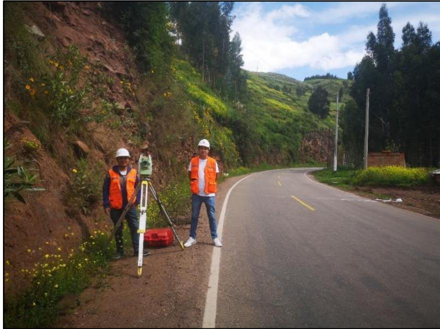
*Figura 244: Georreferenciación de puntos de foto control en el UM-012*
