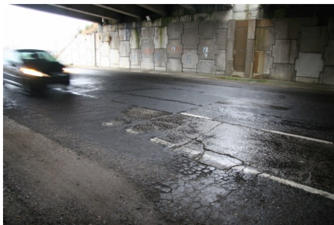
Figura 7: Envejecimiento del asfalto
