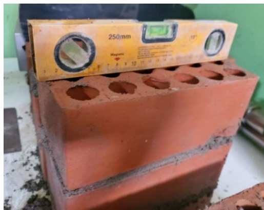
Figura 52: Nivelación de ladrillos.
