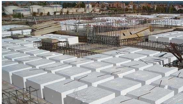
Figura 9: Poliestireno Expandido EPS, en la construcción.
