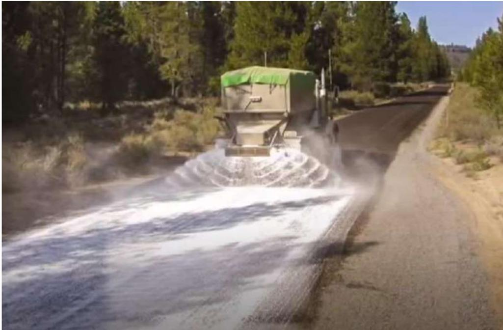
*Figura 15. Control de polvo y estabilización de caminos con cloruros.*
