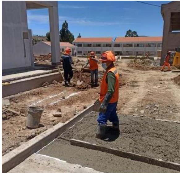
Figura 8. Uso de mascarilla del personal obrero
