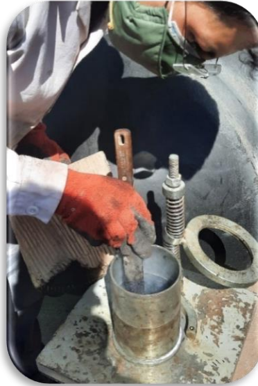
Figura 97: Chuseado de la mezcla asfáltica modificada en caliente.
