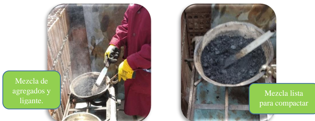
Figura 96: Mezclado de agregados y ligante asfáltico modificado.
