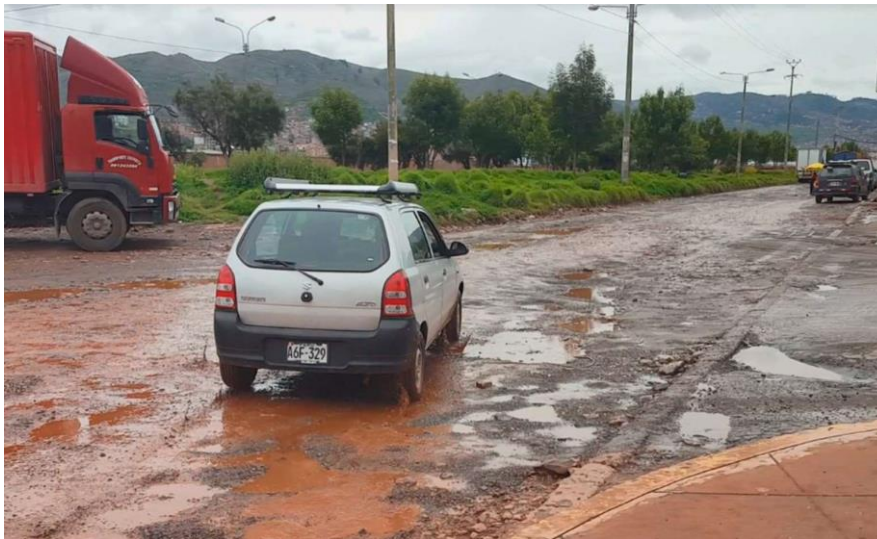
Figura 2. Estado de Vía Expresa.
