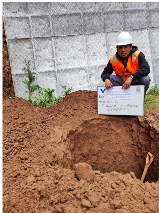
Figura 23. Excavación de calicata APV Sacsaccta.
