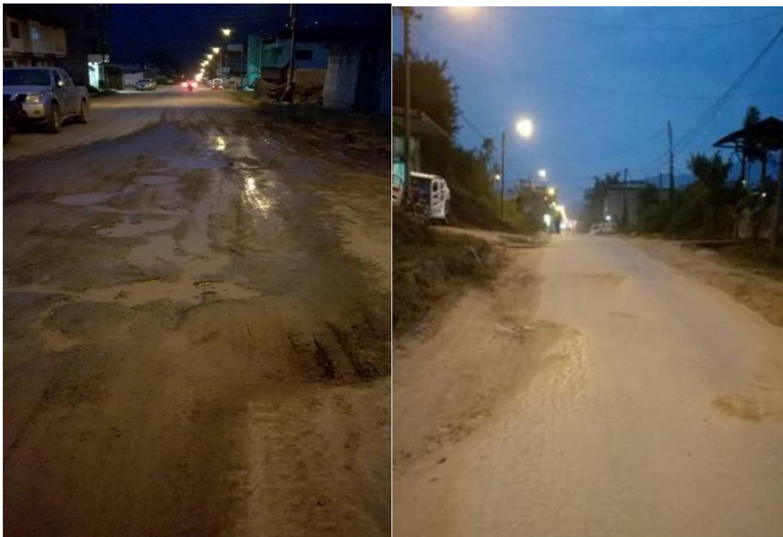
Figura 1. Mejora de suelos finos a nivel de subrasante mediante la adición de cemento Portland.
