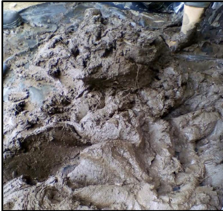
Figura 3: Preparación del barro
