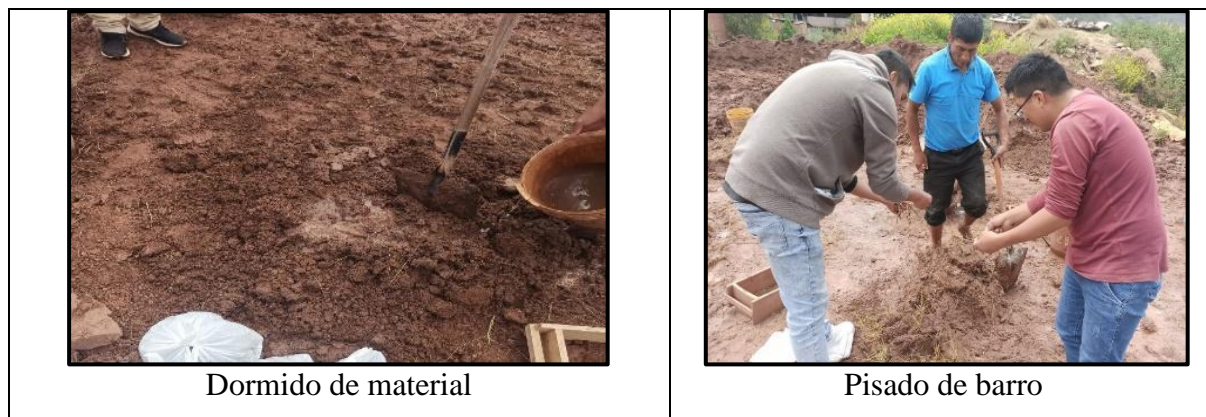
Figura 32: Proceso de elaboración de adobe tradicional
