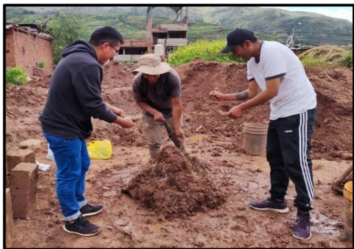
Distribución de paja a la mezcla de barro
