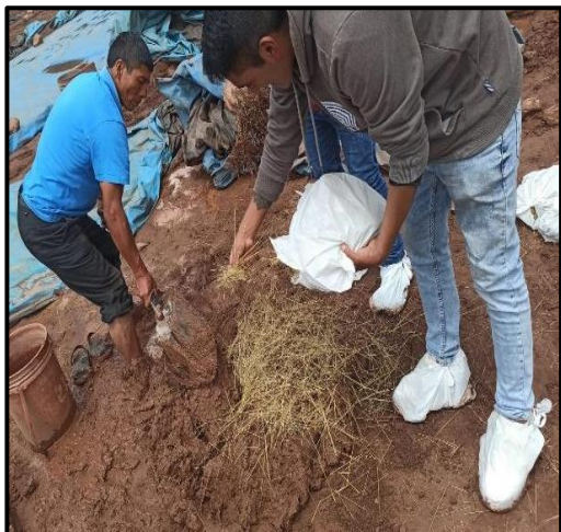
Distribución de paja a la mezcla de barro
