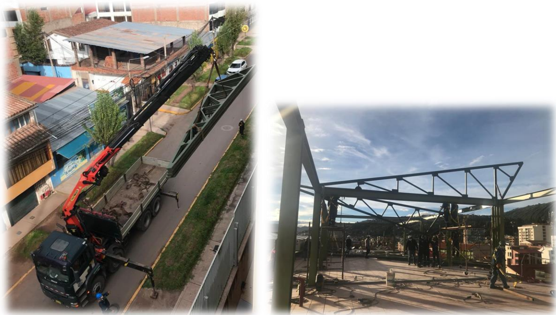
Figura 80 Traslado de tijerales metálicos
