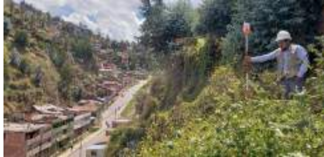
Figura 35: Colocando correctamente el prisma para el levantamiento topográfico
