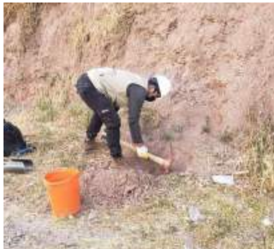
Figura 37: Realizando la Excavación del pozo para el ensayo de infiltración
