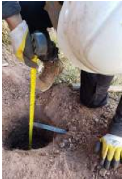
Figura 38: Realizando las mediciones de la profundidad y radio del pozo
