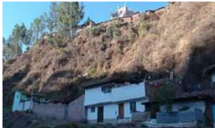
Figura 2: Margen derecha de la Quebrada Ayahuayco
